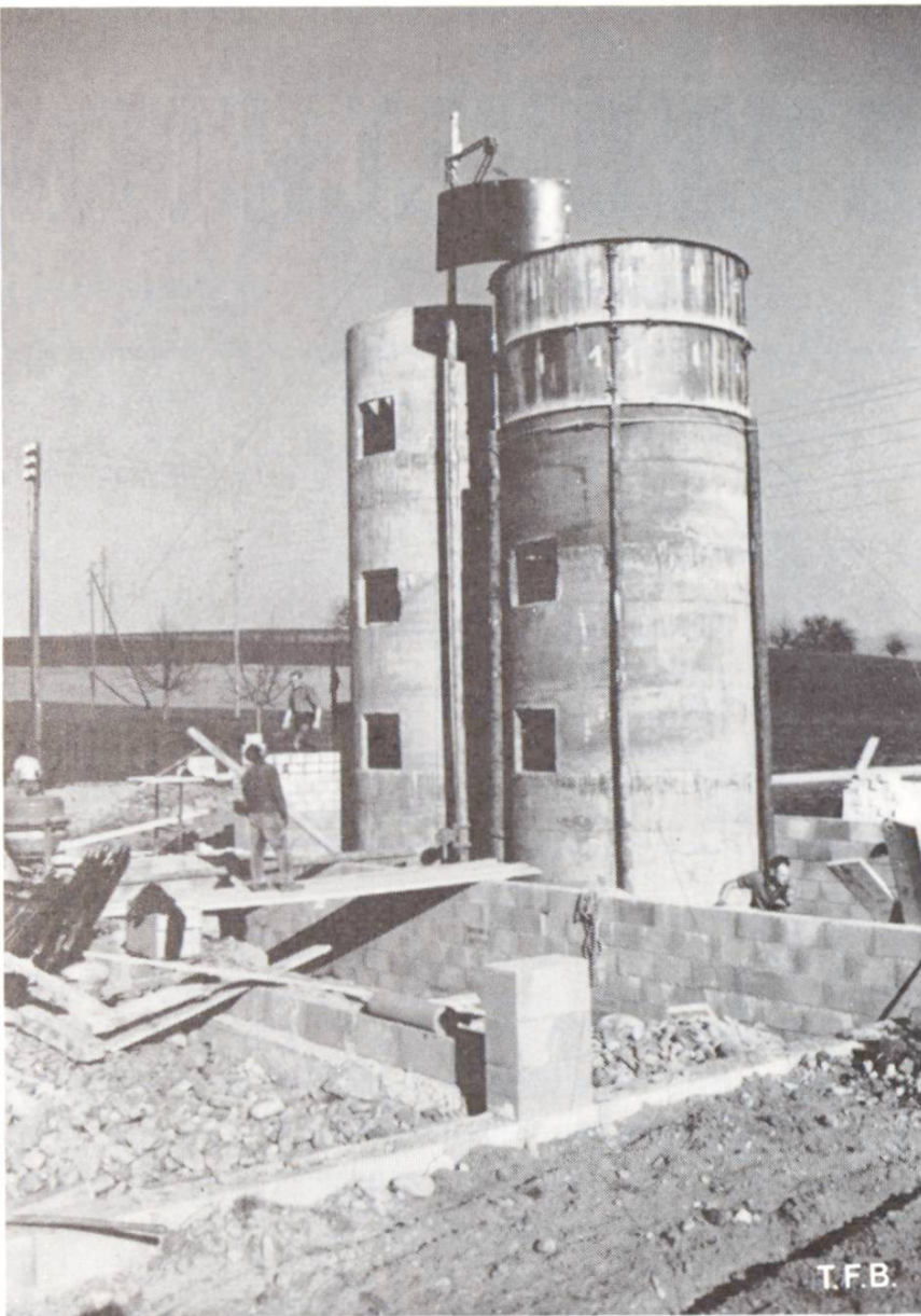
Abb. 2 Betonieren von Hochsilos mit der Steigschalung
