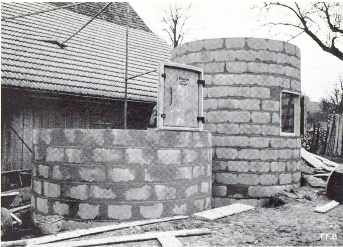
Abb. 3 Erstellung von Grünfuttersilos mit Silo-Formsteinen
