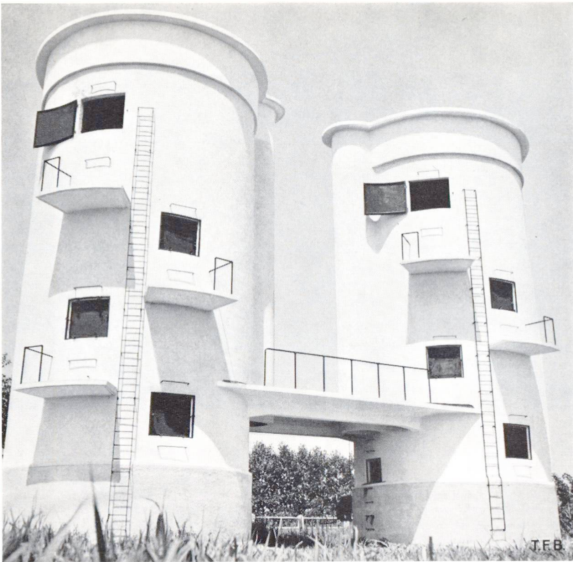
Abb. 9 Siloanlage an der Futterachse plaziert
