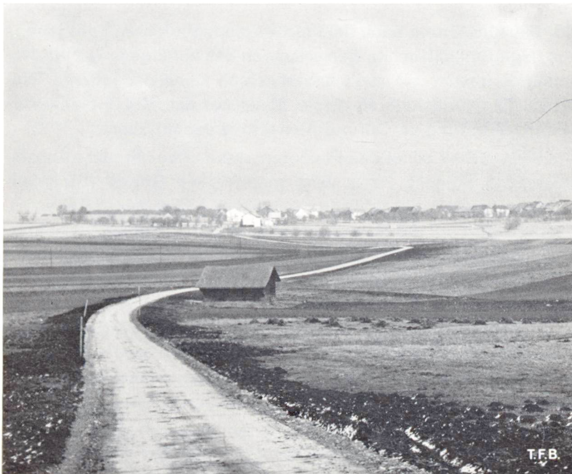
Abb. 6 Zementstabilisierter Feldweg.
