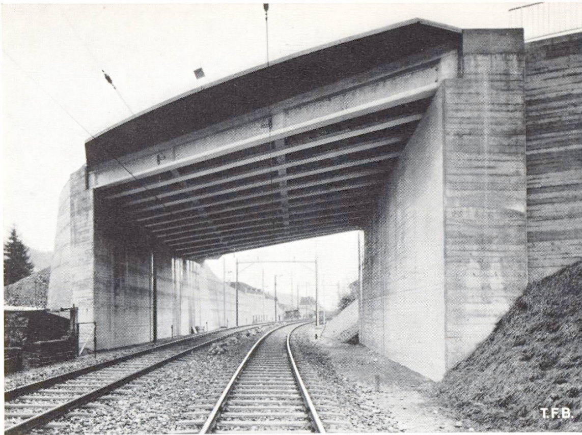
Abb. 3 Strassenüberführung über Eisenbahnlinie mit vorgespannten, vorgefertigten Betonbalken. Vorfabrikation: Vobag, Adliswil.
