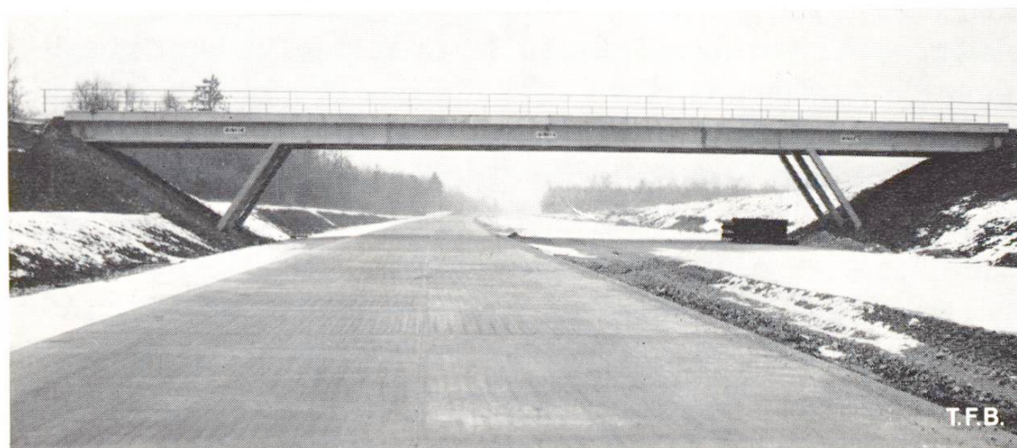
Abb. 4 Ein Schritt voran: Die serienmässig hergestellten und in Montage errichteten Wegüberführungen über die Autobahn Lausanne-Genf. Projekt: Soutter & Schalcher, dipl. Ingenieure, Zürich. Vorfabrikation: Igéco S. A., Etoy VD.
