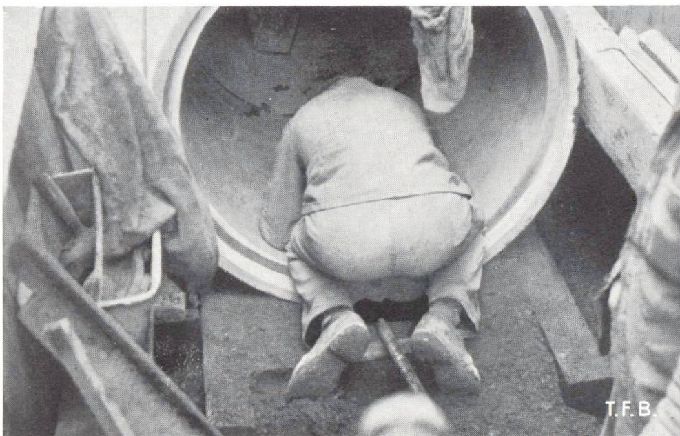
Abb. 7 Versetzen des Rohres auf die frisch vorbetonierte Sohle
