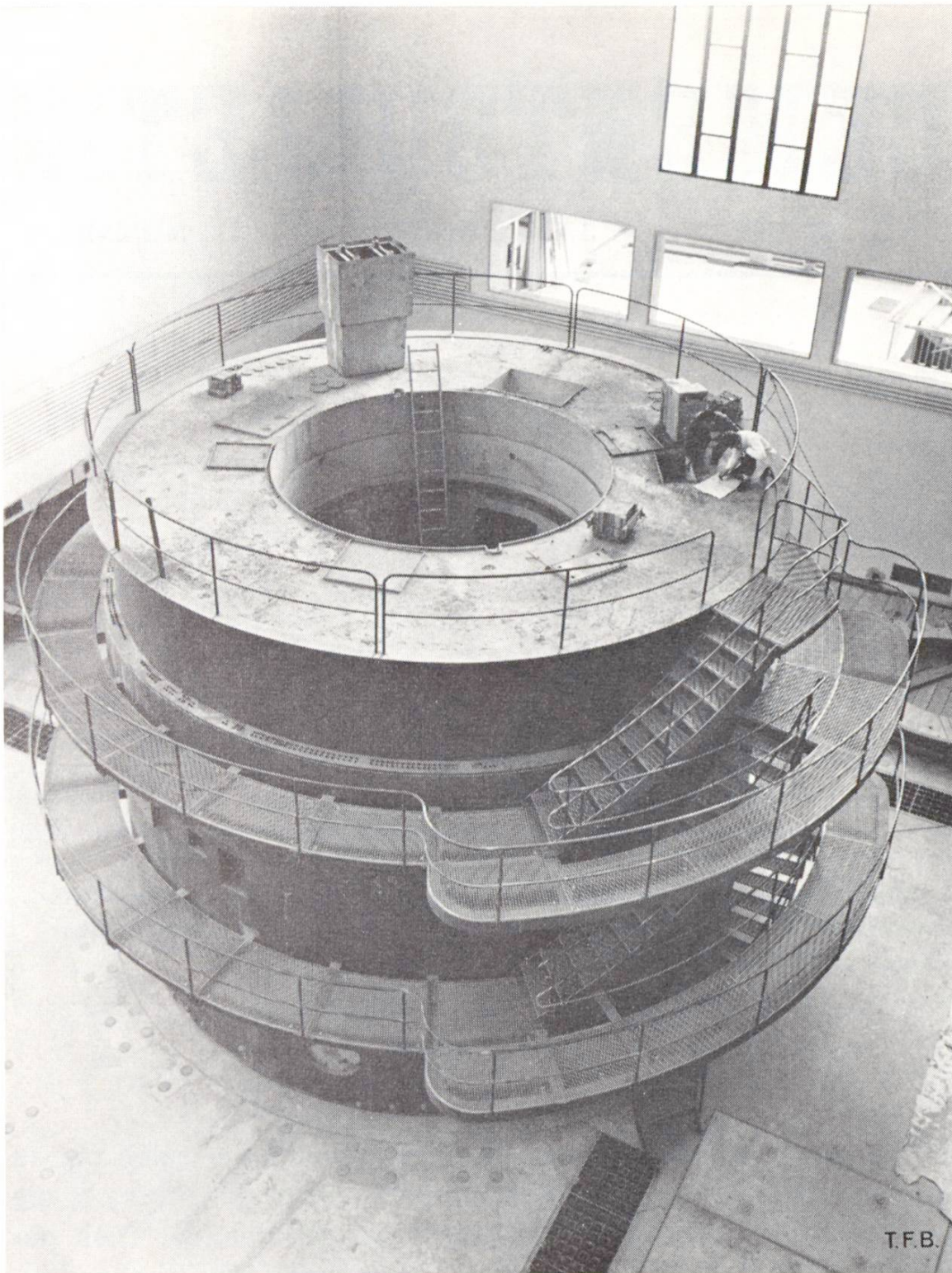
Abb. 1 Reaktorgehäuse im Rohbau fertig erstellt. Das Bild zeigt eindrücklich die wuchtige Masse des Schildes aus schwerem Beton.
