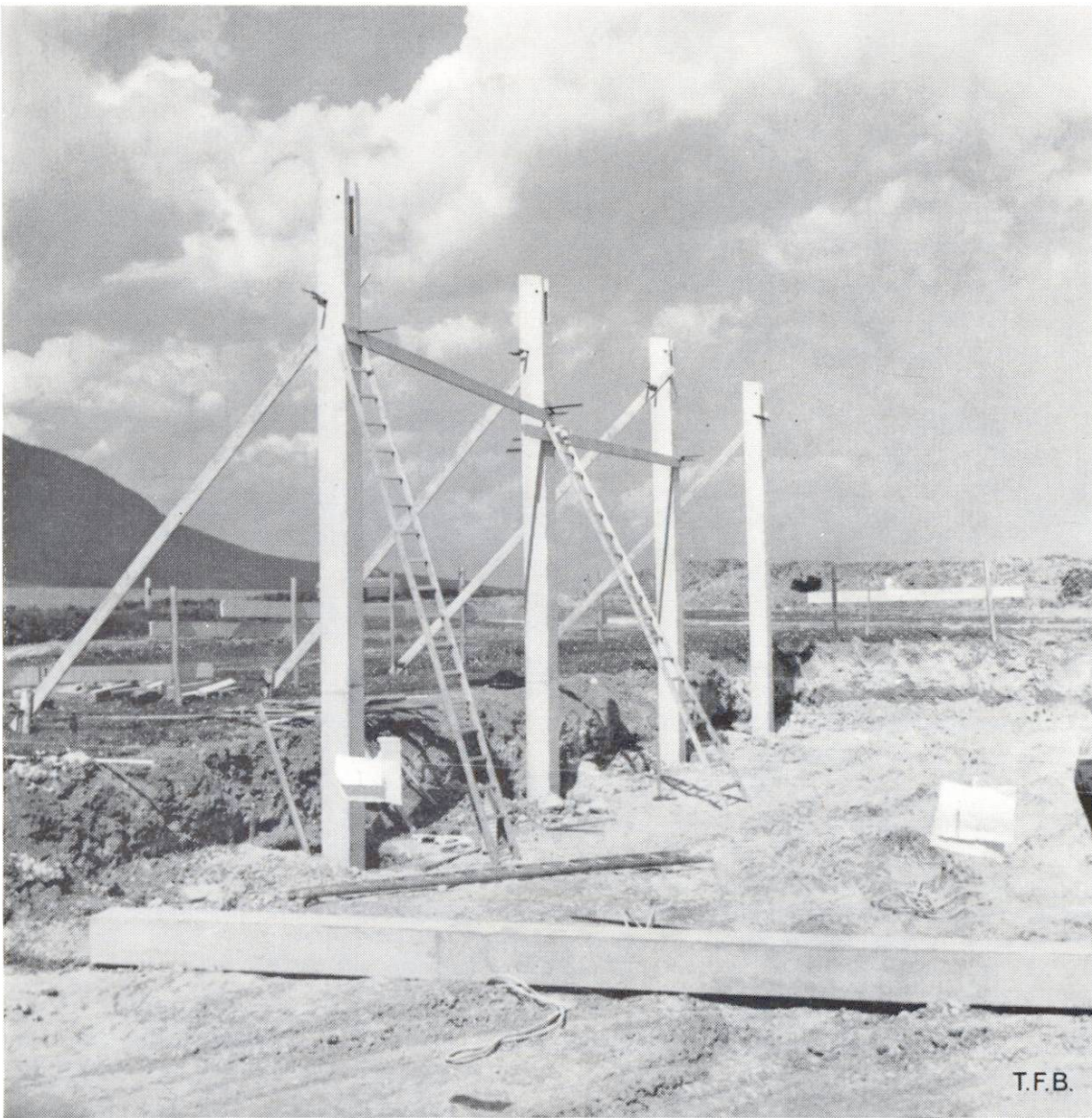
Abb. 2 Stützen, die mit einfachen Mitteln in ihrer provisorischen Lage festgehalten werden.
