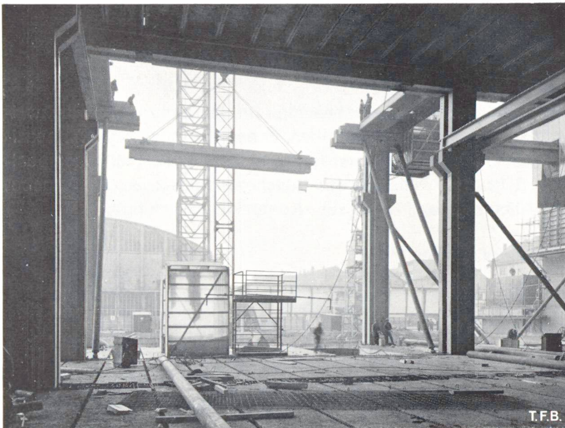
Abb. 6 Einhängen eines Unterzuges auf die Stützenkonsolen. Da die Montage vom Keller aus erfolgte, entstanden Hubhöhen bis zu 34 m, bei welchen die zugelassenen Kranlasten auf 14 t reduziert wurden.
