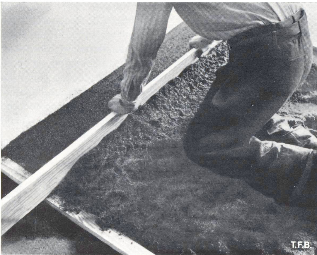
Abb. 2 Abziehen und Verdichten des verteilten Mörtels mit der Latte.
