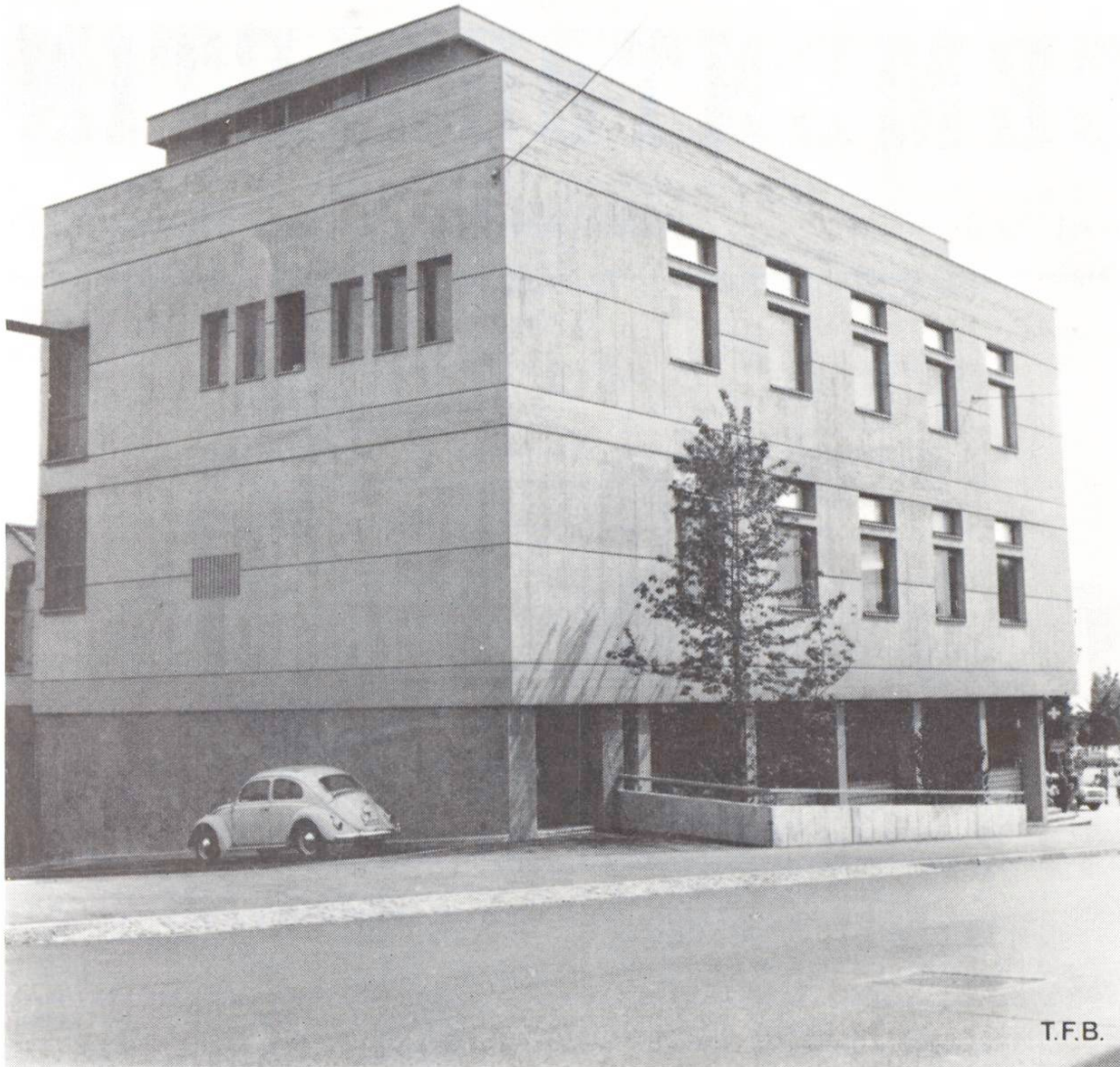
Abb. 10 Sichtbetonbau mit scharf zeichnenden Arbeitsfugen.
