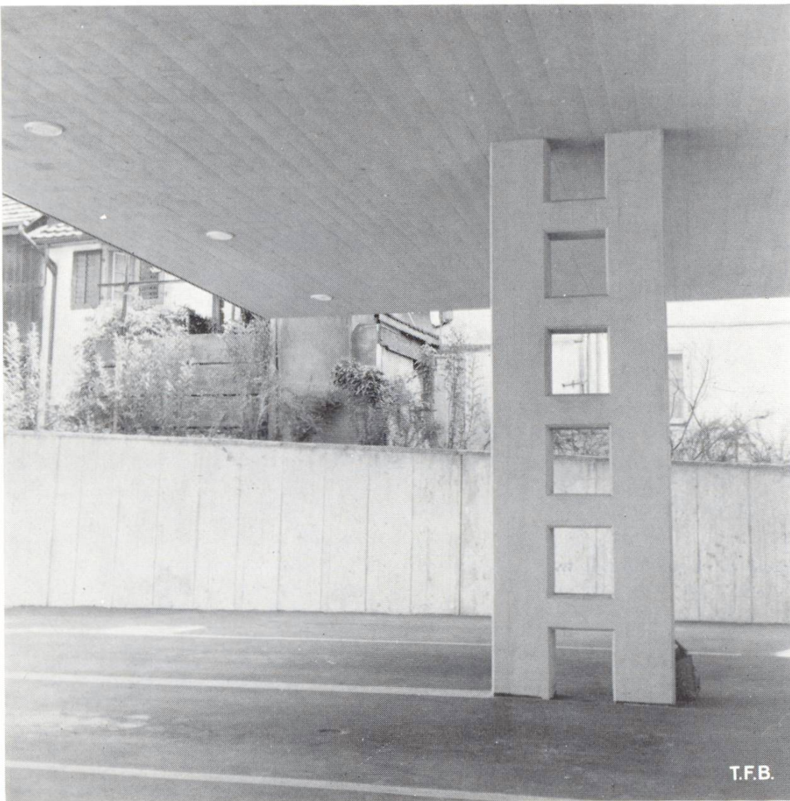
Abb. 16 Derart gegliederte Stützen aus Sichtbeton verlangen eine besonders gute Schalungsarbeit und überlegten Betoniervorgang.
