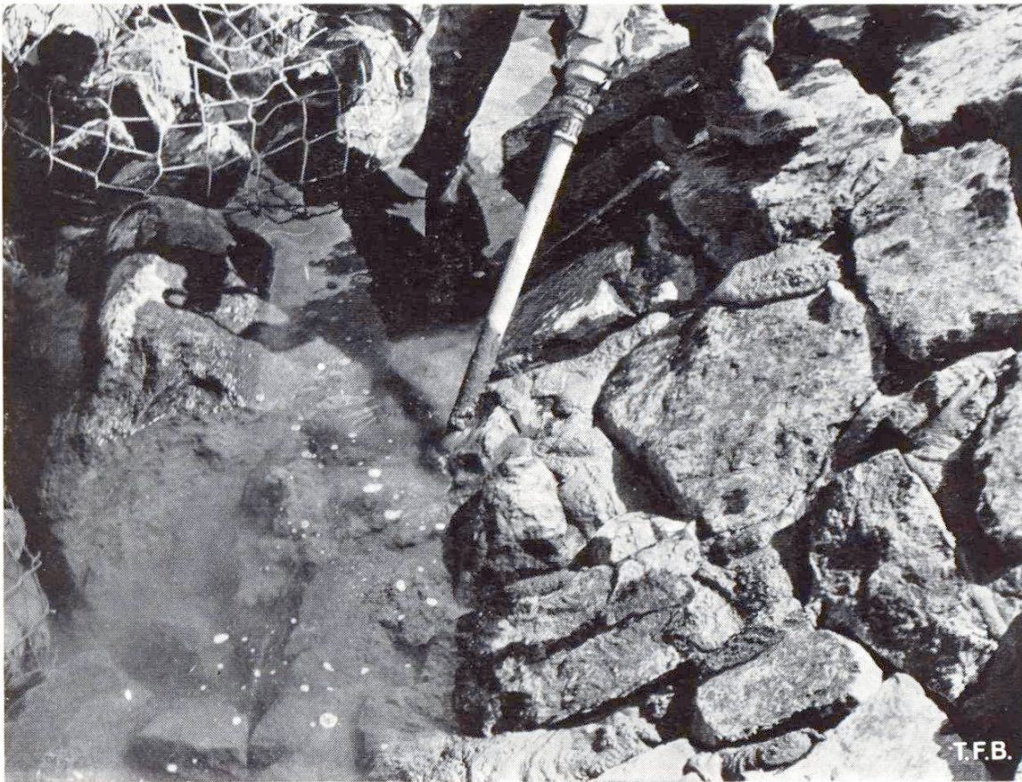
Abb. 4 Vermörtelung unter Wasser.
