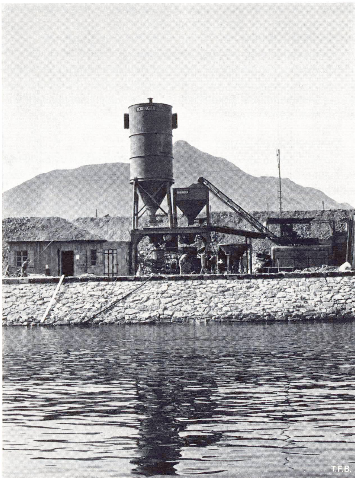
Abb. 2 Aufbereitungsanlage für den Colcrete-Mörtel mit 350-l-Spezialmischer.
