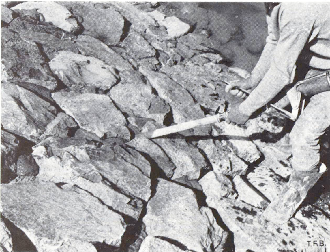
Abb. 3 Vermörtelung über Wasser.
