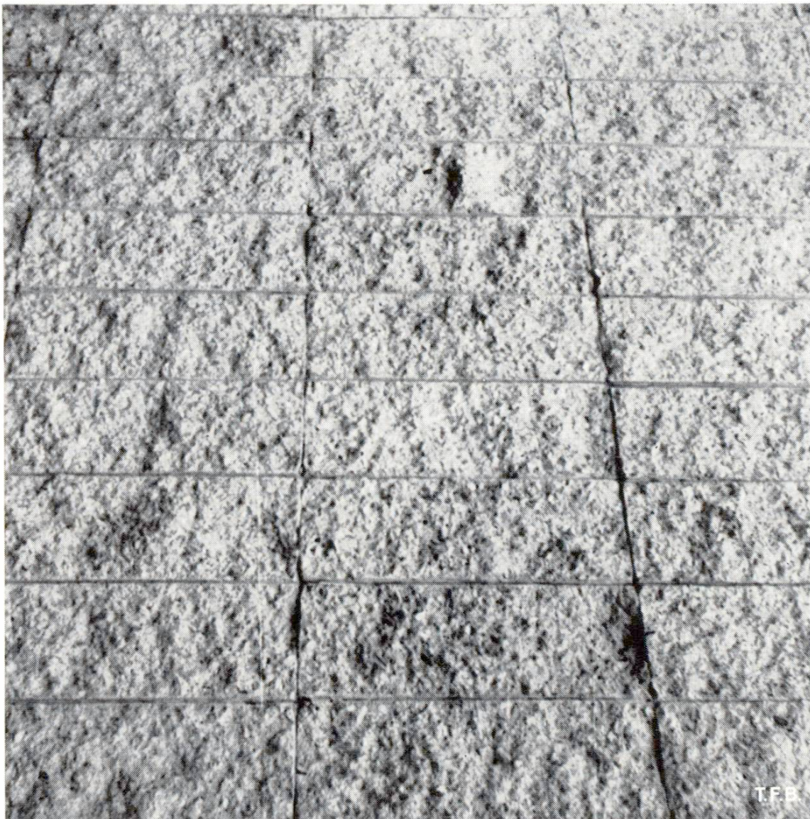
Abb. 4 Sichtmauerwerk mit sehr dünnen Lager- und Stossfugen.
