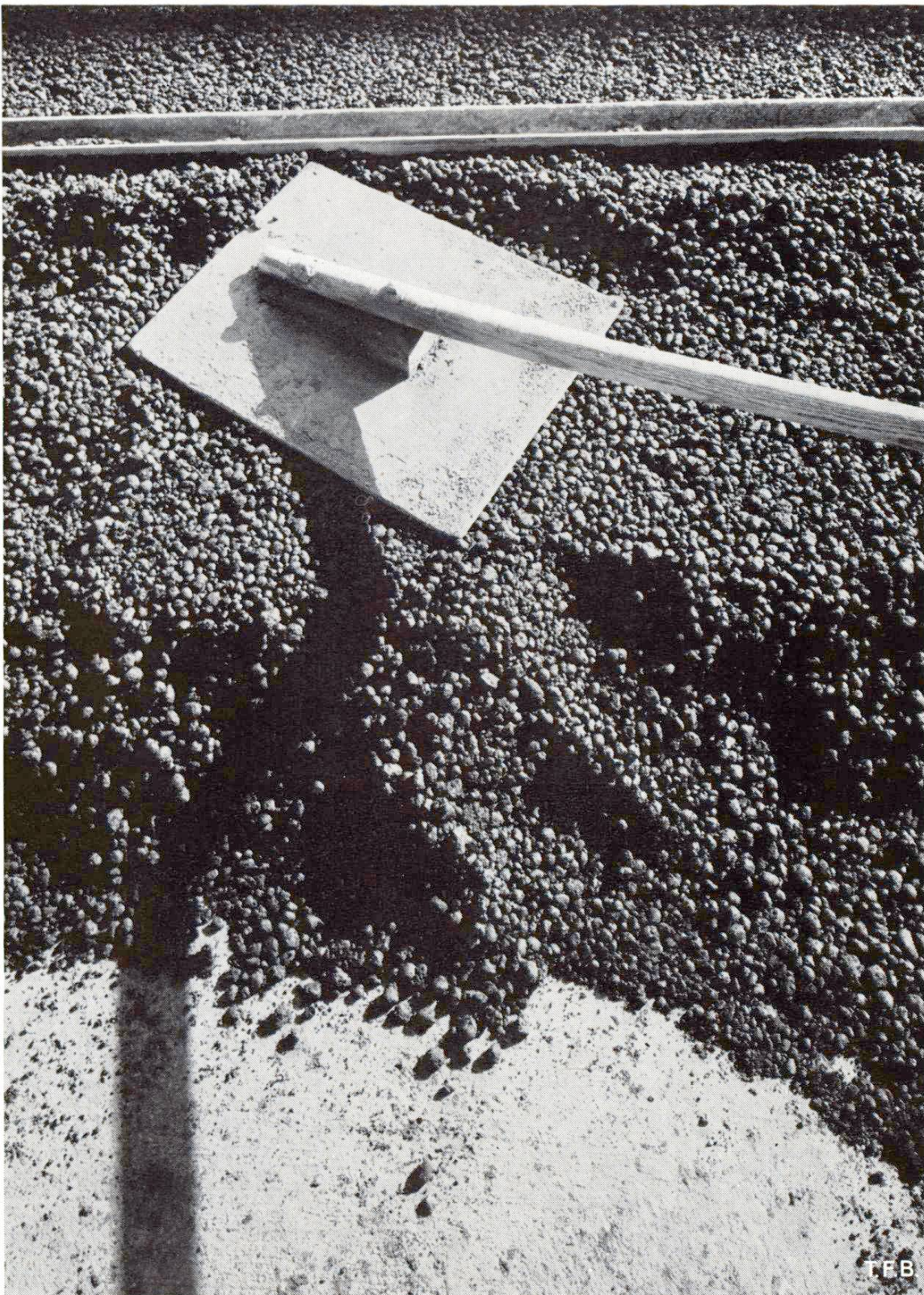
Abb. 9 Verdichten von Leca-Isolationsbeton.
