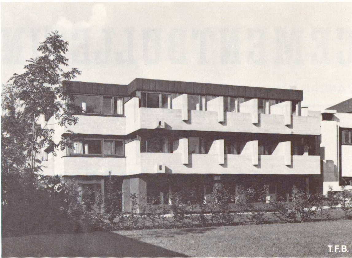
Abb. 1 Paulus-Akademie, Zürich-Witikon Sichtbeton mit Leca zusammengesetzt wie im Text erwähnt Zementdosierung 320 \text{ kg/m}^3 , Aussenwände 35 cm (Architekt Dr. J. Dahinden, Zürich, Ingenieur Desserich & Funk, Luzern)
