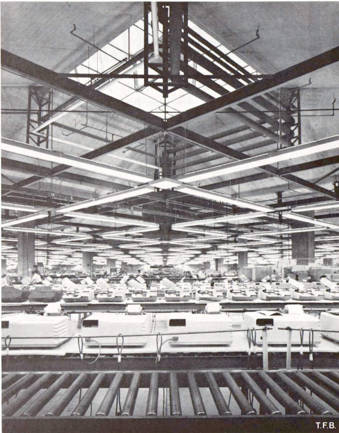
Abb. 1 Der grosse Fabrikationsraum, überdeckt von achteckigen «Trichtern» im Ausmass von 18,30 \times 18,30 m. Kunststoff-Oblichter 6,10 \times 6,10 m. Beleuchtung und alle Installationen sind sichtbar unter dem Betondach aufgehängt. Sie verlaufen in der Diagonale des Stützenrasters.
