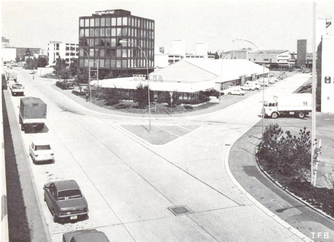
Abb. 7 In der Überbauung «La Praille» in Genf wurde zuerst diese Hauptachse mit den zahlreichen Nebenstrassen aus Beton erstellt. Erst nachträglich entstanden die verschiedenartigen Gebäulichkeiten.
