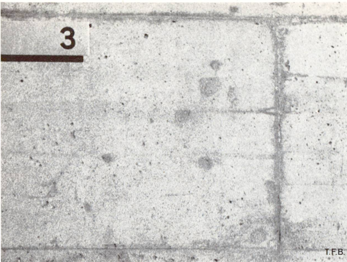
Abb. 5 und 6 Stützmauer mit Anzug wie Abb. 1 und 2. Aufnahmen 1962 bzw. 1972. Gut verdichteter Beton P 300 aus imprägnierten Schalntafeln. Allgemeine Dunklerfärbung infolge Bewuchs und Auflösung der obersten Kalkhaut. Anfänglich dunkle Streifen entlang der Schalungsfugen zeichnen heute hell. Dies ist die Folge der Nachhydratation und des geringeren Bewuchses der an diesen Stellen äusserst dichten und zementreichen Betonoberfläche. Zahlreich sind auch die scheinbar neuen Luftlöcher, die aber ursprünglich nur durch eine dünne Zementhaut bedeckt waren. Die Abzeichnungen der Holzäste treten heute stärker hervor als ursprünglich. Dies ist die Folge des stärkeren Bewuchses an Stellen grösserer Porosität. Ähnliches gilt auch für die scharfe Abzeichnung undichter Schalungsfugen. Der markante Flecken im unteren Eck der Schalungstafel ist komplexer Natur. Astholz, Undichtigkeit und Entmischung haben hier eine besonders starke Porosität des Zementsteins hervorgerufen.
