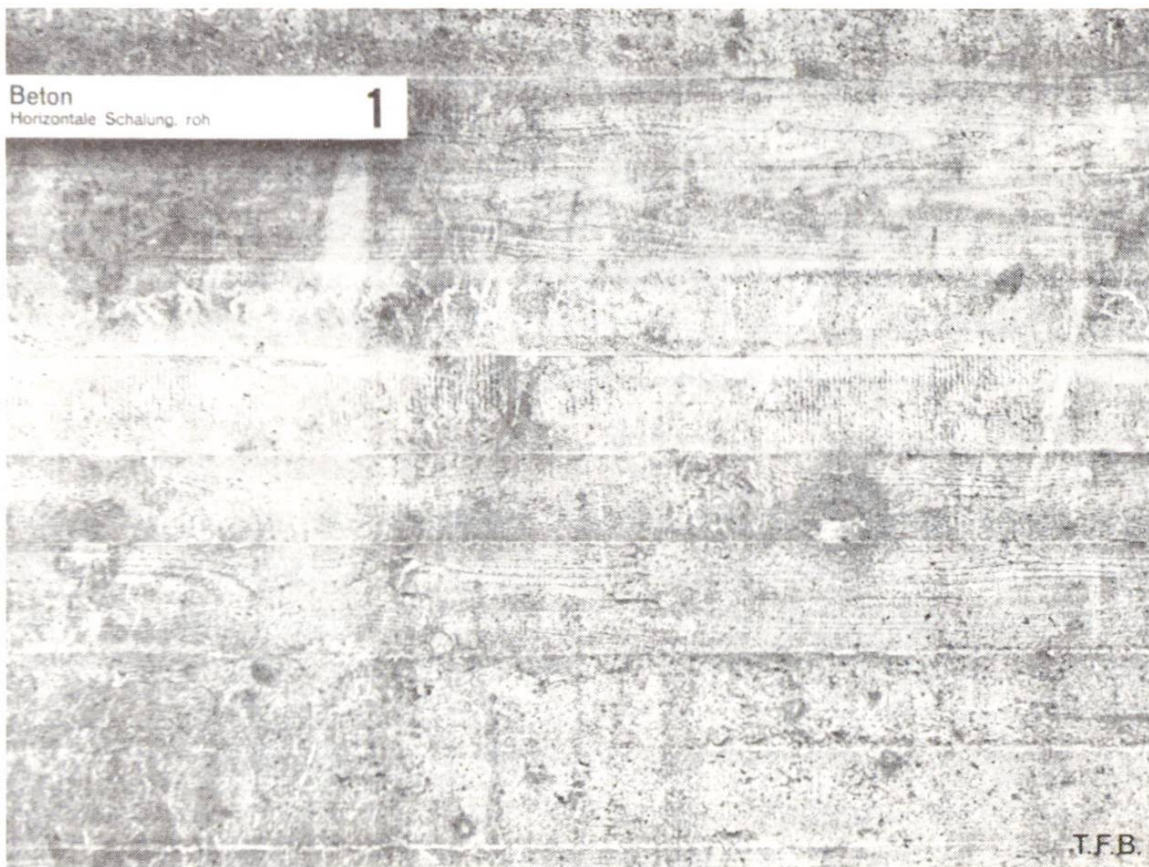
Abb. 1 und 2 Stützmauer mit Anzug 8:1, vollständig der Witterung ausgesetzt. Fotoaufnahmen: Abb. 1 im Mai 1962, Abb. 2 im März 1972. Beton P 300 aus roher Bretterschalung. Im Verlaufe der Zeit ist die Betonoberfläche allgemein etwas dunkler geworden, was hier hauptsächlich auf den flechtenartigen Bewuchs zurückzuführen ist, der gut haftende, verkohlte Rückstände hinterlässt. Die Ansiedlung von Flechten, niederen Algen und Pilzen konzentriert sich auf poröse Stellen der Betonoberfläche, welche die Feuchtigkeit länger zurückhalten. Unterhalb der Metallplatte, wo Wasser von derselben auf die Betonoberfläche abtropft, ist der Bewuchs zufolge der Wirkung der Metallsalze spärlicher. Auch Stellen stärkerer Kalkausscheidungen zeigen weniger Flechtenbefall.
