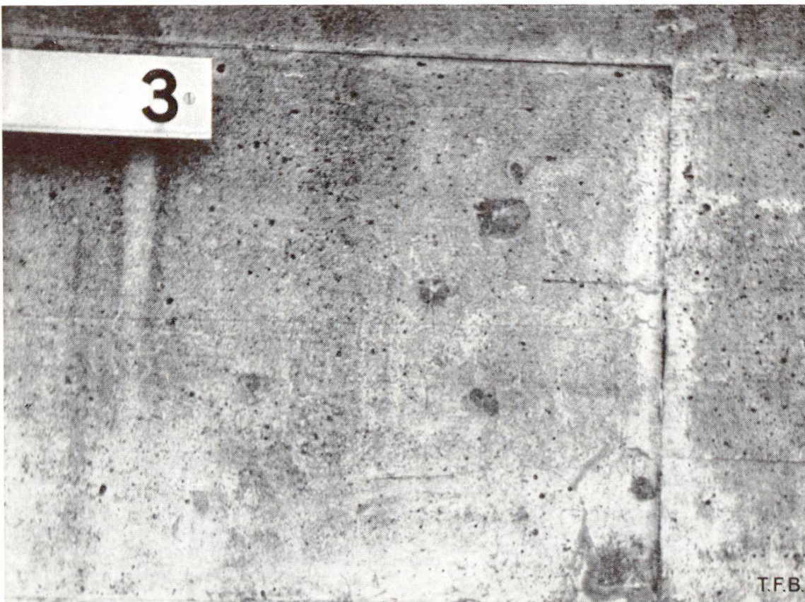
Abb. 5 und 6 Stützmauer mit Anzug wie Abb. 1 und 2. Aufnahmen 1962 bzw. 1972. Gut verdichteter Beton P 300 aus imprägnierten Schalntafeln. Allgemeine Dunklerfärbung infolge Bewuchs und Auflösung der obersten Kalkhaut. Anfänglich dunkle Streifen entlang der Schalungsfugen zeichnen heute hell. Dies ist die Folge der Nachhydratation und des geringeren Bewuchses der an diesen Stellen äusserst dichten und zementreichen Betonoberfläche. Zahlreich sind auch die scheinbar neuen Luftlöcher, die aber ursprünglich nur durch eine dünne Zementhaut bedeckt waren. Die Abzeichnungen der Holzäste treten heute stärker hervor als ursprünglich. Dies ist die Folge des stärkeren Bewuchses an Stellen grösserer Porosität. Ähnliches gilt auch für die scharfe Abzeichnung undichter Schalungsfugen. Der markante Flecken im unteren Eck der Schalungstafel ist komplexer Natur. Astholz, Undichtigkeit und Entmischung haben hier eine besonders starke Porosität des Zementsteins hervorgerufen.
