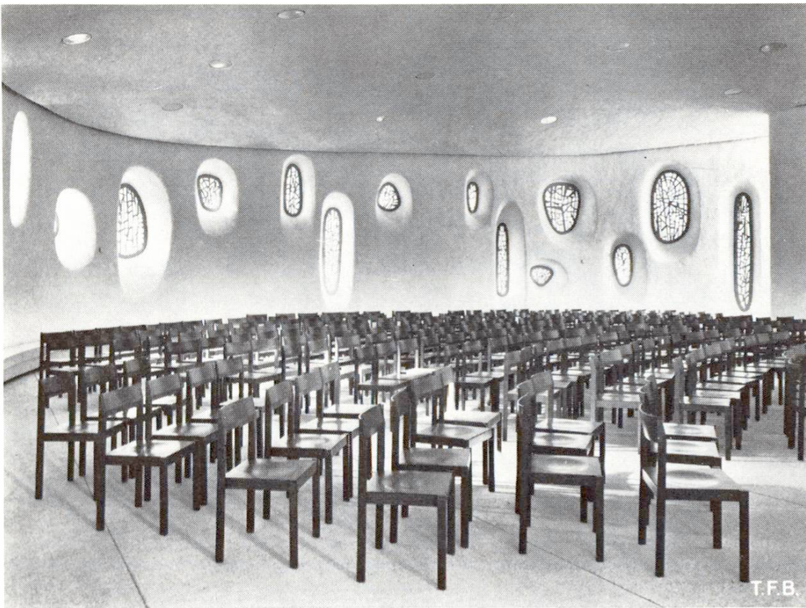
Abb. 5 Innenseite der Kirche St-Jean in La Chaux-de-Fonds. Die freie Formgebung durch Spritzbeton kommt hier besonders bei den Fensterdurchbrüchen zur Geltung. Grundlage der Fenster waren zwei ineinanderpassende ausgesteifte Rahmen aus Winkeleisen, von denen der äussere während des Spritzvorganges einbetoniert wurde und der innere in die Werkstatt des Kunstglasers gebracht worden ist. Auch die Decke wurde im Spritzbetonverfahren in mehreren Schichten aufgebaut, wobei vom zentralen Turm tragende Streifen radial gegen aussen angeordnet worden sind. Dazwischen wurde wiederum Füllmaterial aus Schaumstoff eingelegt. Die Deckenuntersicht wurde auf eine zusätzliche Isolationsschicht aufgespritzt.
