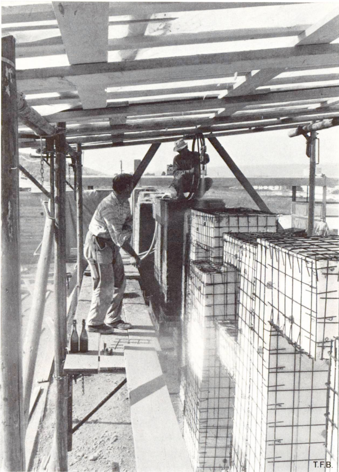
Abb. 2 Künstlerisch gestaltete Reliefmauer. Kernkörper aus Schaumstoffblöcken entsprechend der gewünschten Form. Stahldrahtnetze als Armierung im Abstand von 2–3 cm.
