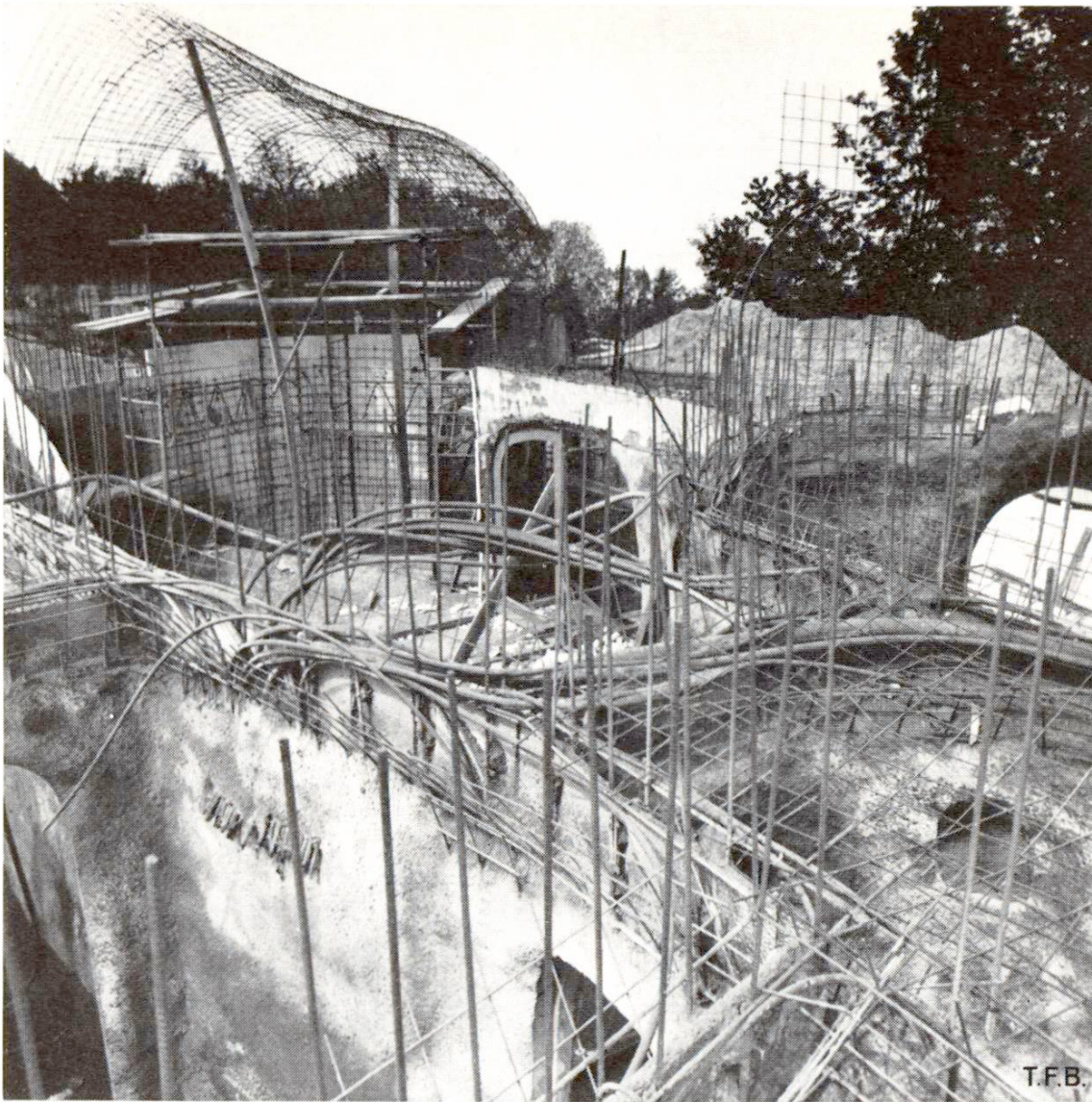
Abb. 2 Übersicht über die Installation vor Inangriffnahme des zweiten Geschosses.
