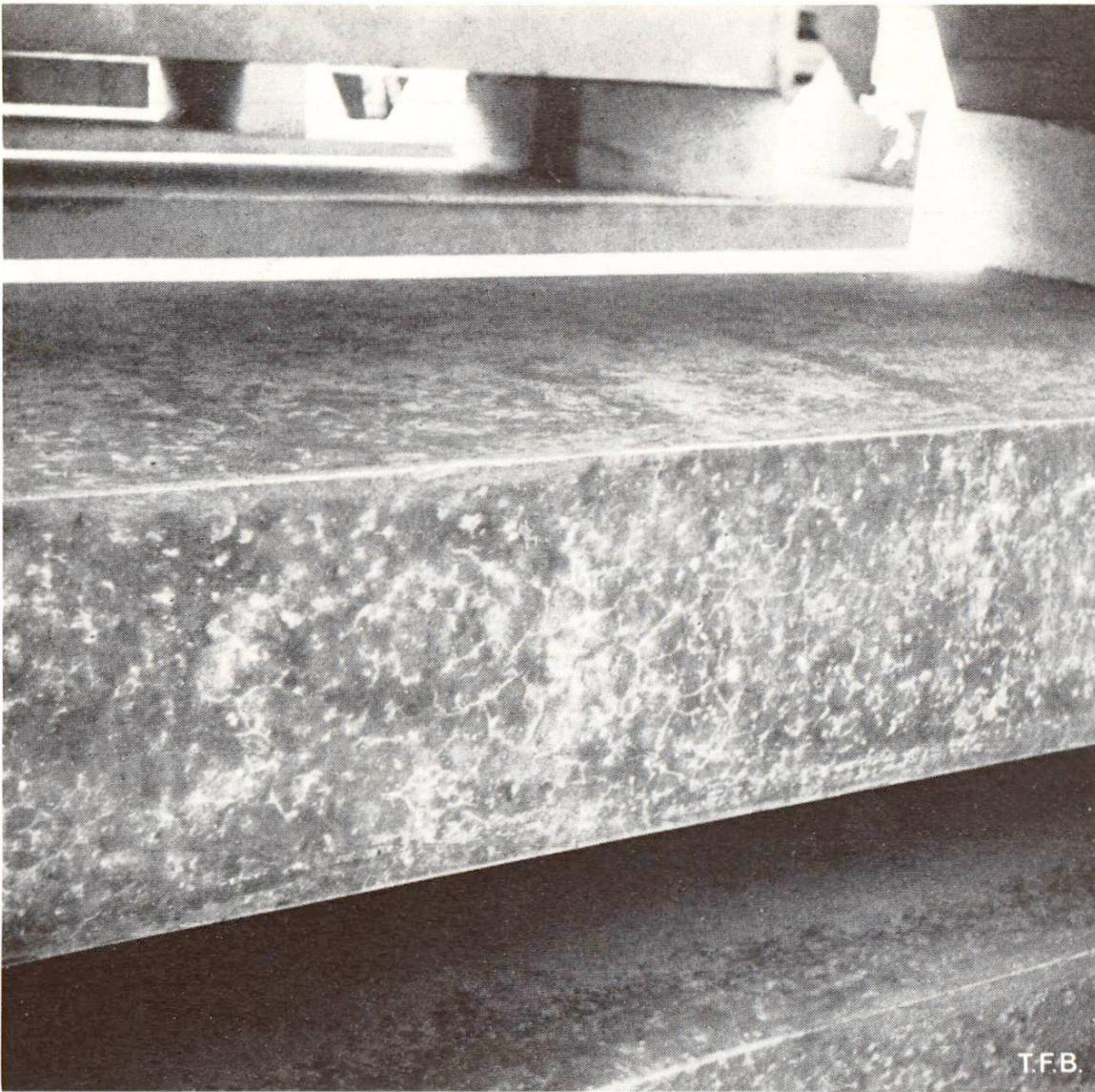
Abb. 6 Hell zeichnende feine Netzrisse an einem Betonelement aus Stahlschalung, Konzentration in der Flächenmitte, entstanden vermutlich aus Temperaturdifferenzen infolge hoher Zementdosierung. Der Beton ist sehr dicht und deshalb dunkel geblieben. Nur im Bereich der feinen Risse konnte sich heller Kalk ausscheiden.
