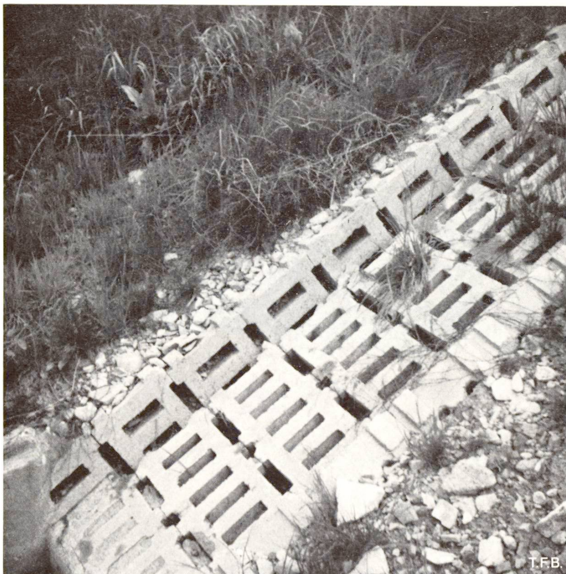
Abb. 7 Beispiel einer kleinen Hochwasserentlastung an einem Strassendamm.
