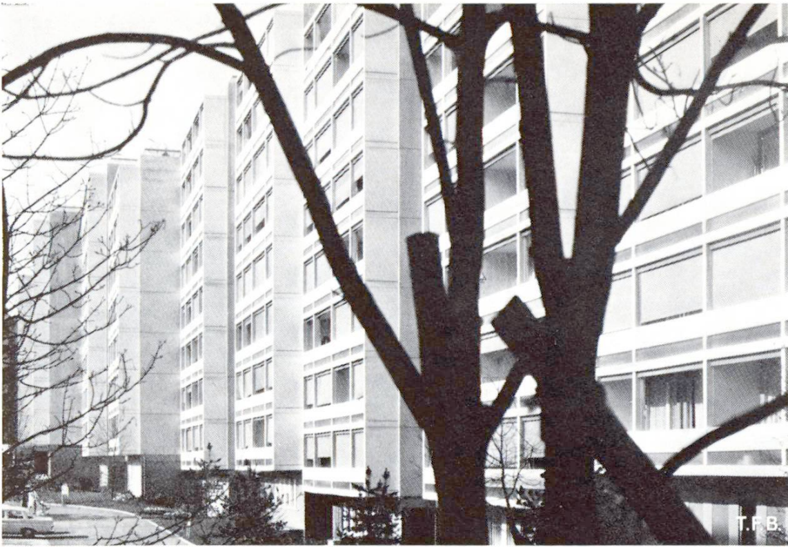
Abb. 5 Moderner Wohnungsbau mit glatten, sorgfältig hergestellten Betonelementen Architekt: Nauer & Scheurer, Bern Ingenieur: Bächtold, Robert & Co., Bern Vorfabrikation: Igéco
