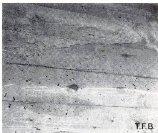
Abb. 6 Unter Druck nachgebende Schalung
