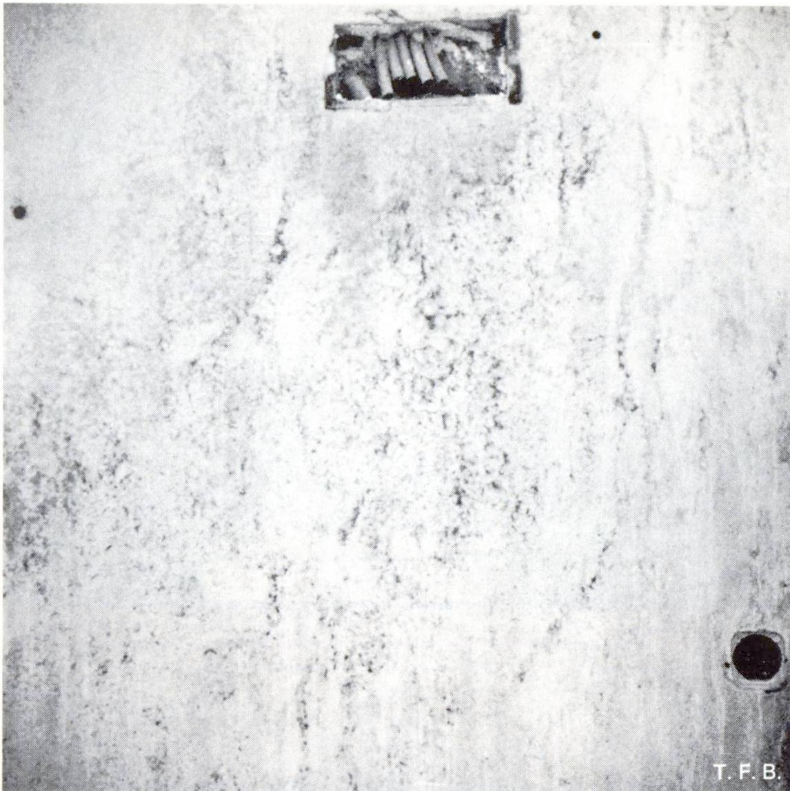
Abb. 5 Wasserausscheidung im Bereich der Schalungsfläche infolge eines zu hohen Wassergehaltes. Die Betonmischung wurde auch zu wenig durchgearbeitet.
