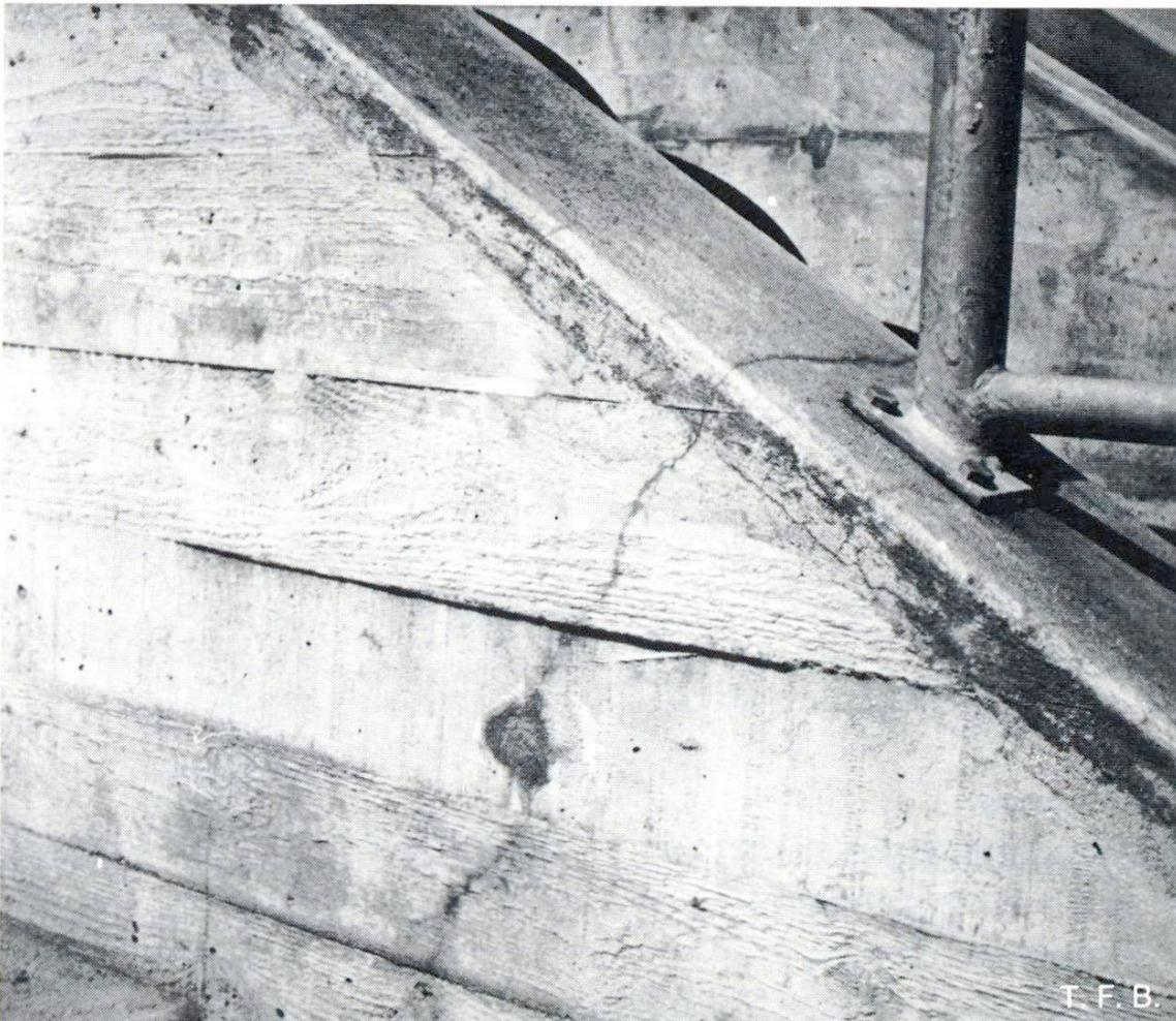
Abb. 4 Auch die nachträgliche Herstellung einer glatten Krone an einer Sichtbetonmauer kann als Reparatur angesehen werden. In solchen Fällen sollte man wenn immer möglich die Krone unmittelbar nach dem Betonieren, ohne Hinzufügung von Mörtel, abreiben, glätten und formen.
