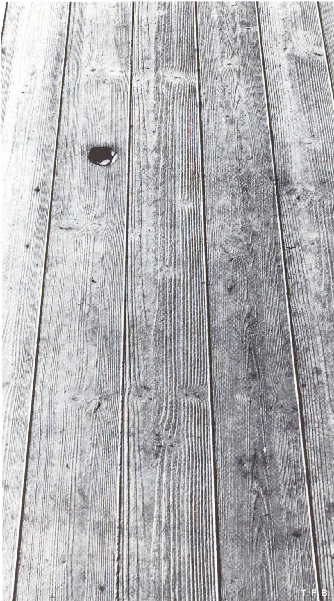
Abb. 2 Betonoberfläche aus der Schalung Abb. 1.
