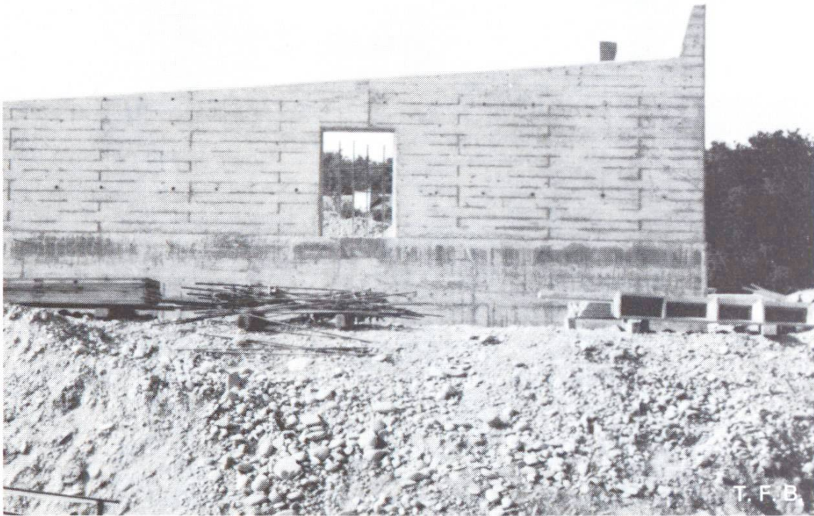
Abb. 5 Sichtbeton aus Tafelschalung mit versetzten Stossfugen.
