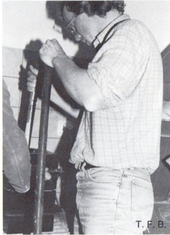
Verdichten eines Probewürfels
