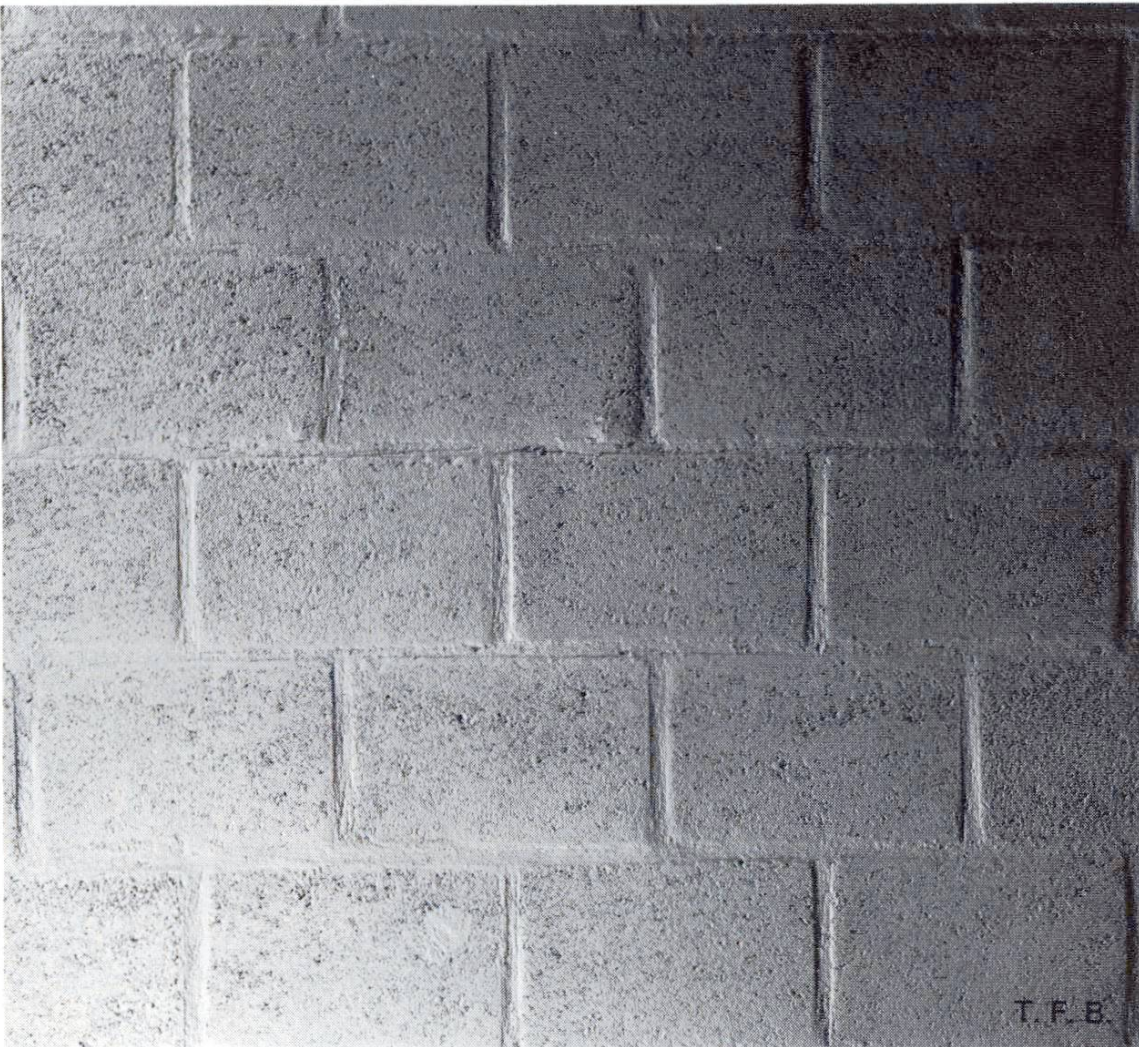
Abb. 9 Aus der Oberflächenbeschaffenheit der Betonsteine ergeben sich kleine Tönungsunterschiede von Stein zu Stein, die meistens eine willkommene Belebung darstellen.
