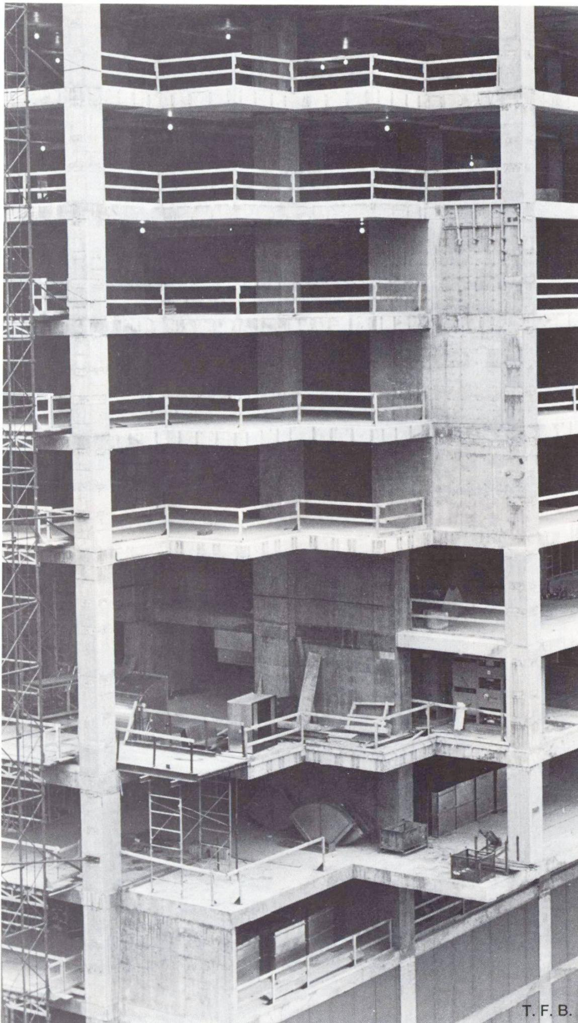
Abb. 7 Übersicht über die Zwischenwände vom 9. bis 15. Boden. Die äusseren Scheinstützen mit Hängerfunktion und die entsprechenden Erweiterungen der Bodenplatten 10. bis 12. wurden nachträglich erstellt.
