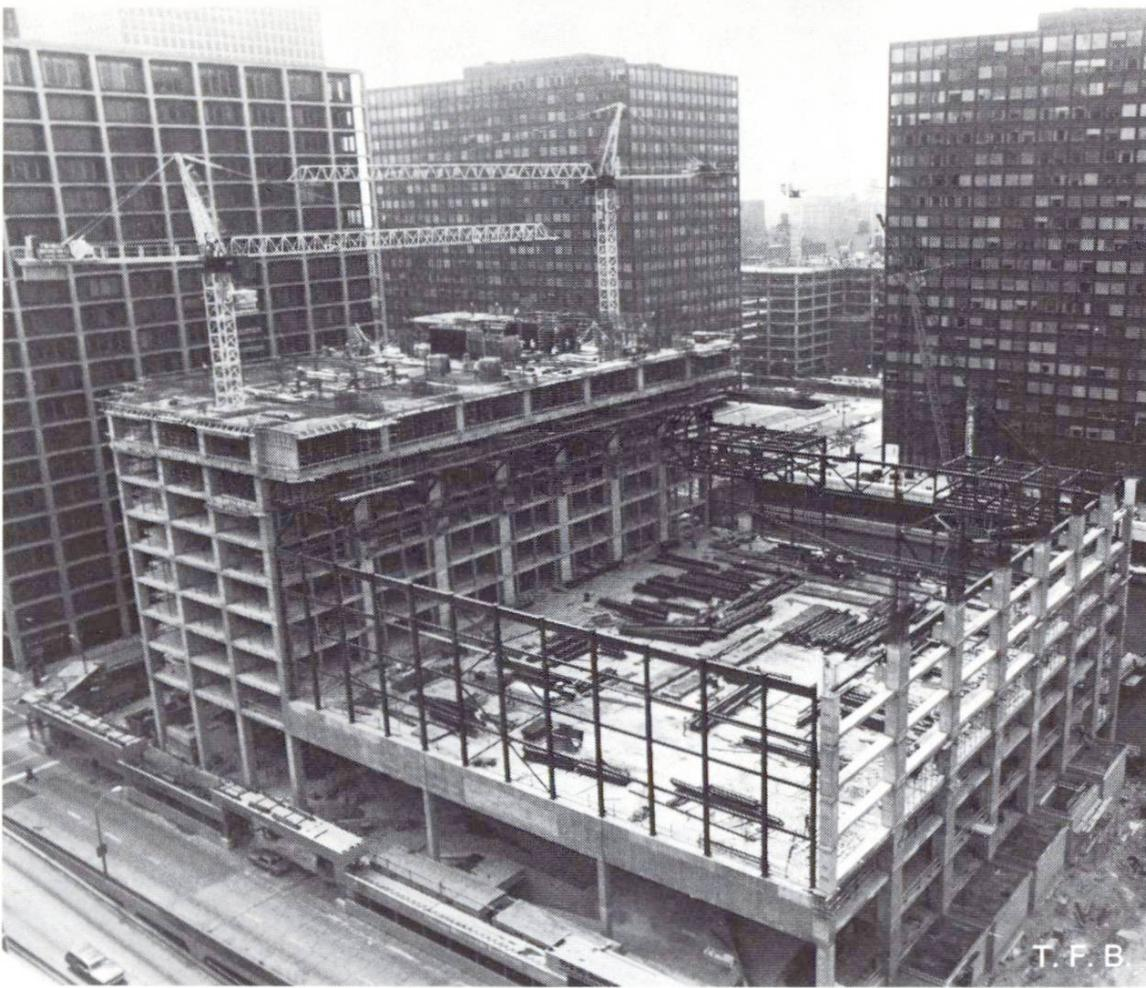
Abb. 8 Übersicht der Baustelle mit Turm I bis zum 9. Boden und der grossen Börsenhalle, die mit ihren 3700 m<sup>2</sup> mehr als die Hälfte des Grundstückes einnimmt.
