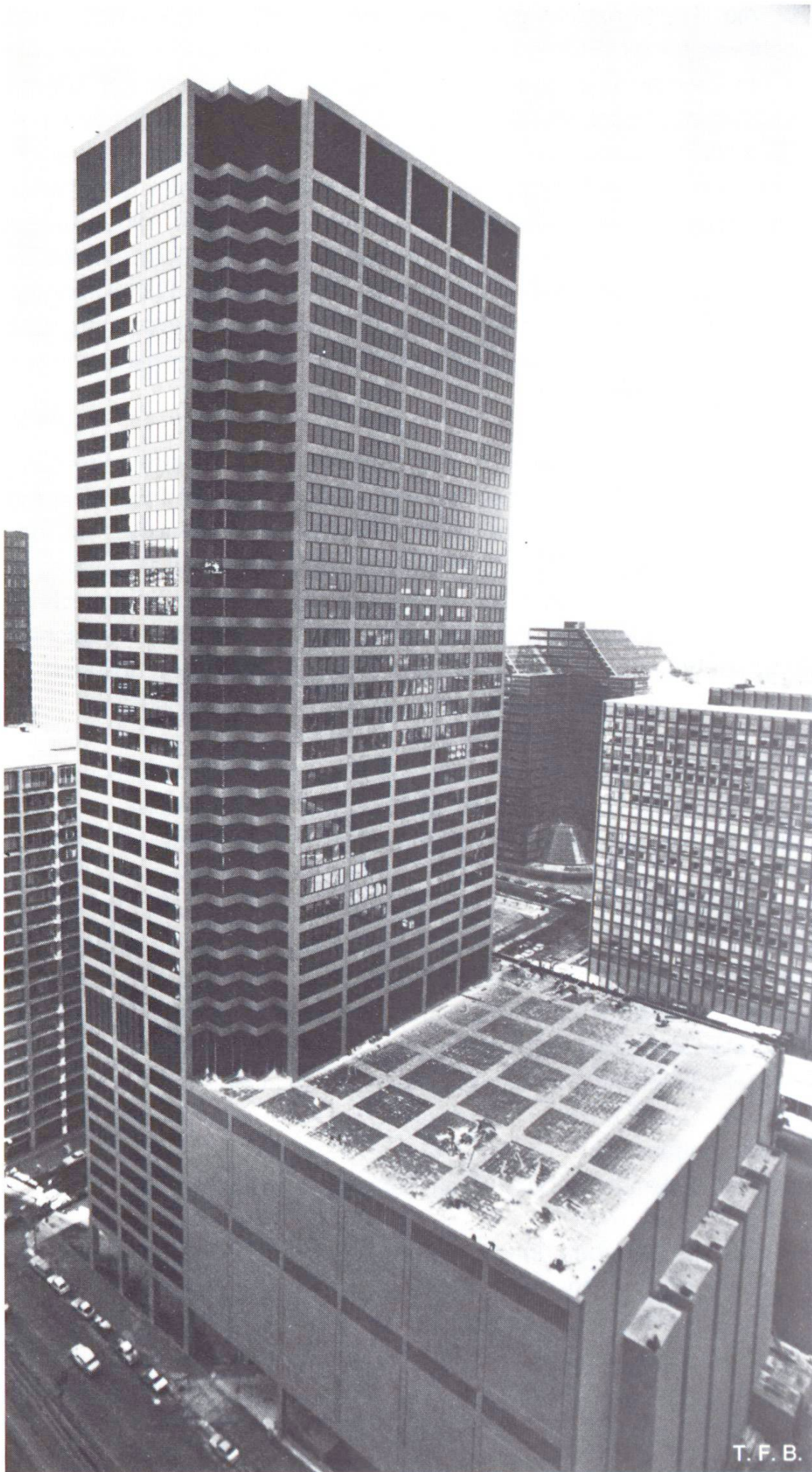
Abb. 10 Bauwerk nach Fertigstellung der 1. Bauphase, Dezember 1983.
