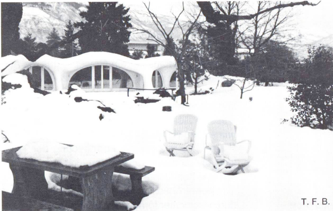
Abb. 9 Blick auf ein erdüberdecktes Einfamilienhaus mit tragenden Teilen aus Spritzbeton.
