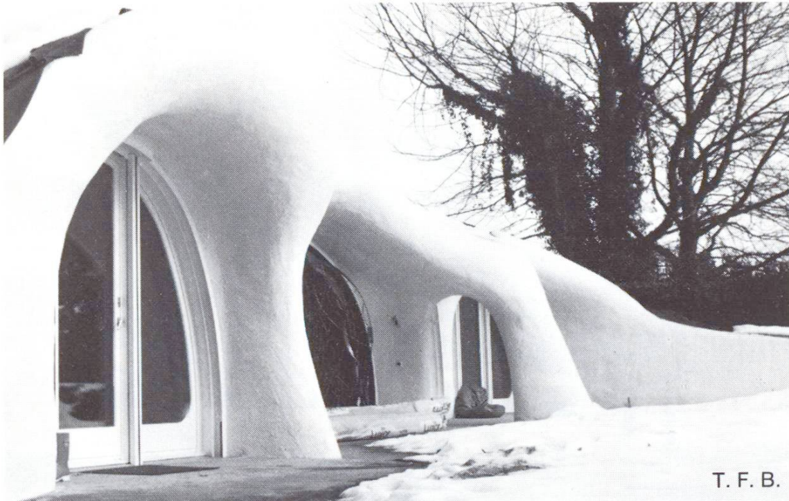
Abb. 8 Aussenisolation aus Polyurethan, das gleichzeitig die endgültige Formgebung bewirkt. Farbstrich der sichtbaren Teile.
