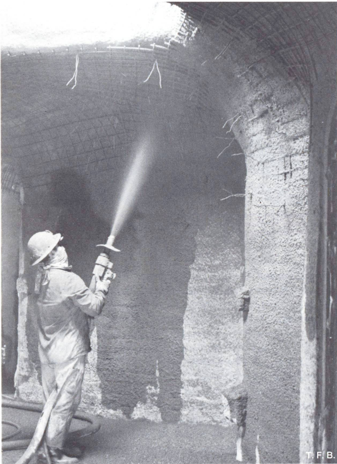
Abb. 5 Auftrag der zweiten Spritzbetonschicht.
