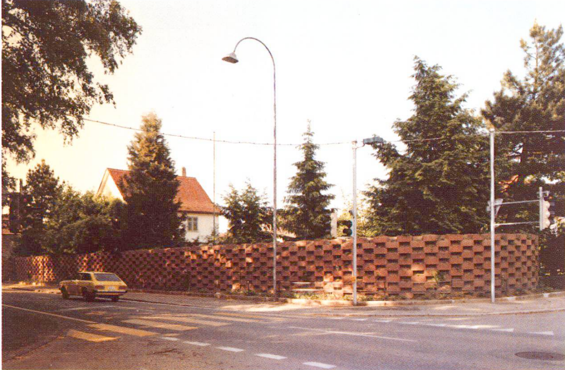
Abb. 3 Abschirmung eines Privatgrundstücks gegen eine stark befahrene Strassenkreuzung. Typ L aus Elementen von 50 \times 20 \times 60 cm und 50 kg Gewicht.
