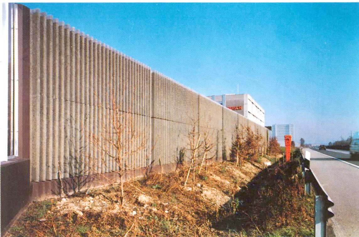
Abb. 8 Lärmschutzwand entlang der N1 bei Lonay VD. Zweifarbige Ausführung, Wandelemente Typ Structa (Höhe variabel, max. 5 m lang). Hohe Schallabsorption durch Rippen- oder Spundwandstruktur. Zur sauberen Anböschung wird ein Fundamentthals angeordnet. Anstatt in Ortsbeton kann er als Schürze des untersten Elements vorfabriziert werden.
