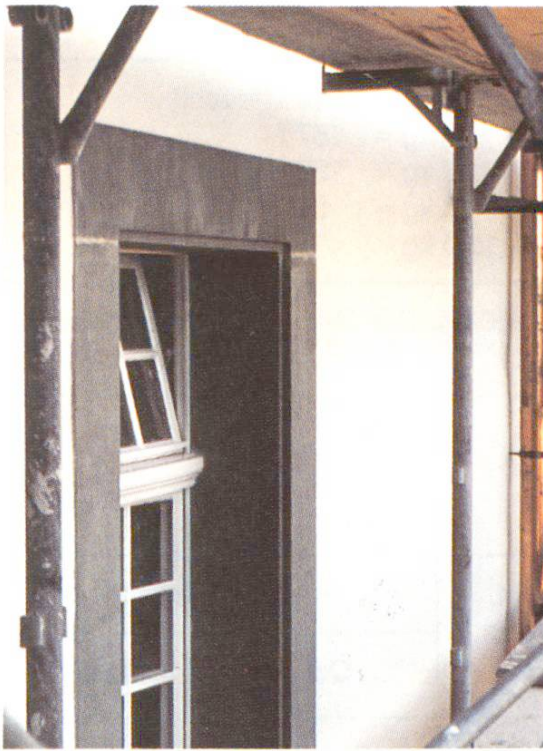
Abb. 4 Detail Nordfassade. Neue Fenstereinfassungen, neuer Verputz, gestrichen.
