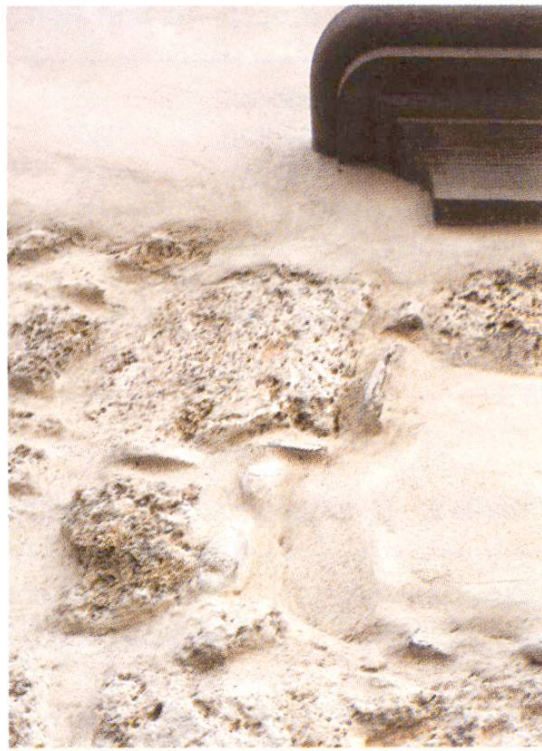
Abb. 5 Übergang von verputztem Mischmauerwerk zu ausgefugtem Quadermauerwerk. Oben rechts: Fensterbank.
