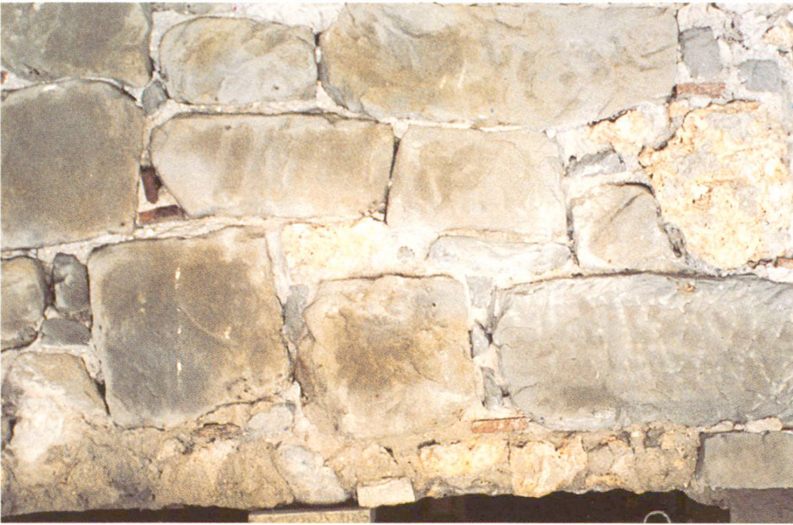
Abb. 3 Das Mischmauerwerk wurde mit Stopfmörtel ausgefugt und verputzt.
