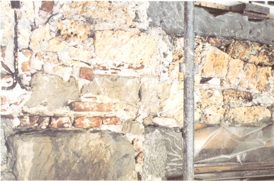
Abb. 2 Mischmauerwerk mit abgespitzter Fenstereinfassung in Sandstein (oben rechts).
