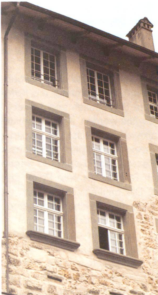
Abb. 6 Ausschnitt der Nordfassade.
