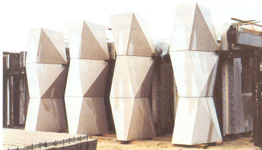
Elemente Typ A und B, bereit zum Transport auf die Baustelle. 7
