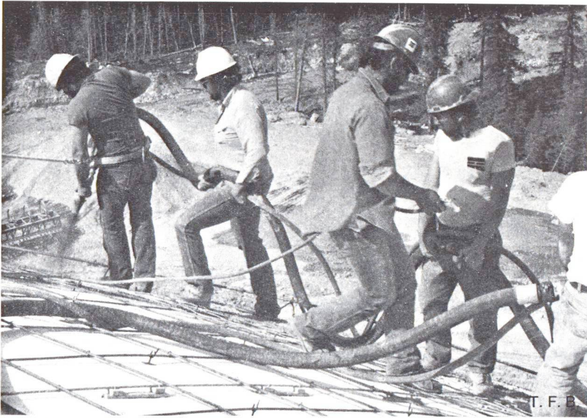
Abb. 8 Spritzbetonarbeiten, erste Schicht.
