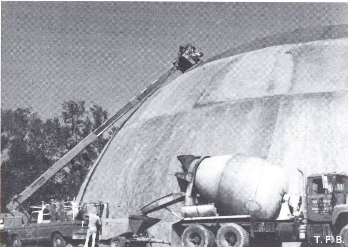
Abb. 9 Aufspritzen und Abtalschieren der zweiten Spritzbetonschicht. Anschliessend wird eine Abdichtung aufgebracht.
