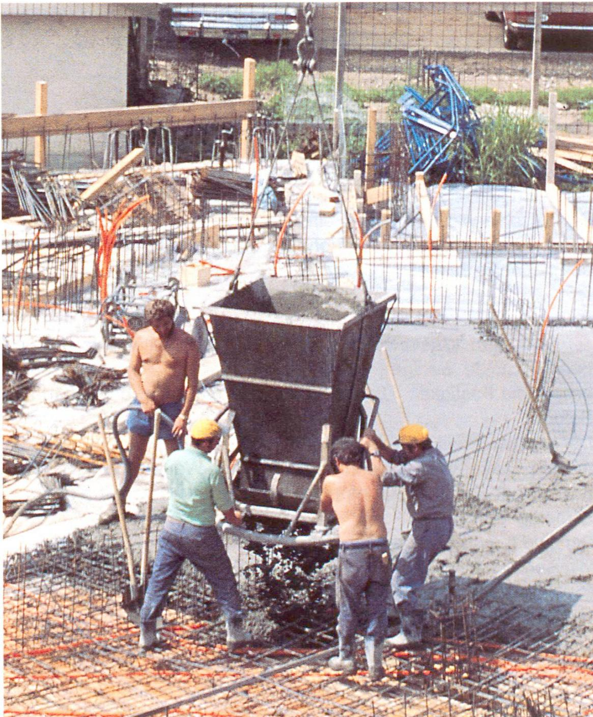
**1 Beton** entsteht durch Vermischen von *Zement* mit den *Zuschlagstoffen* Kies und Sand unter Zugabe von *Wasser*. Normalerweise enthält 1 m<sup>3</sup> Beton 300–350 kg Zement, ungefähr 2000 kg Zuschlagstoffe und 130–200 l Wasser. Je nach Verwendungszweck können dem Beton noch *Zusätze* beigegeben werden (Zusatzmittel: etwa 0,5–10,0 kg/m<sup>3</sup>. Zusatzstoffe: etwa 5–50 kg/m<sup>3</sup>).
