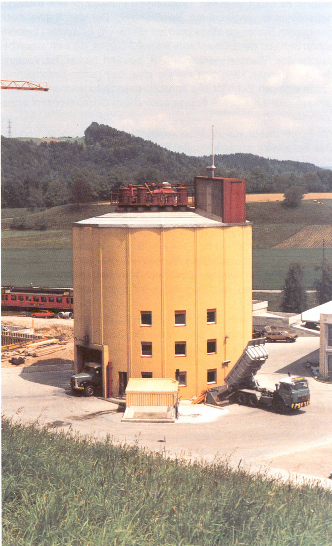
Abb. 10 Das fertige Werk in Betrieb. Einstweilen werden die Zuschlagstoffe noch mit Lastwagen zugeführt.
