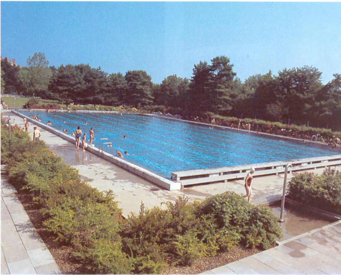
Schwimmerbecken mit Überflutungsrinne längsseitig und Startbank stirnseitig (Reinach BL)
