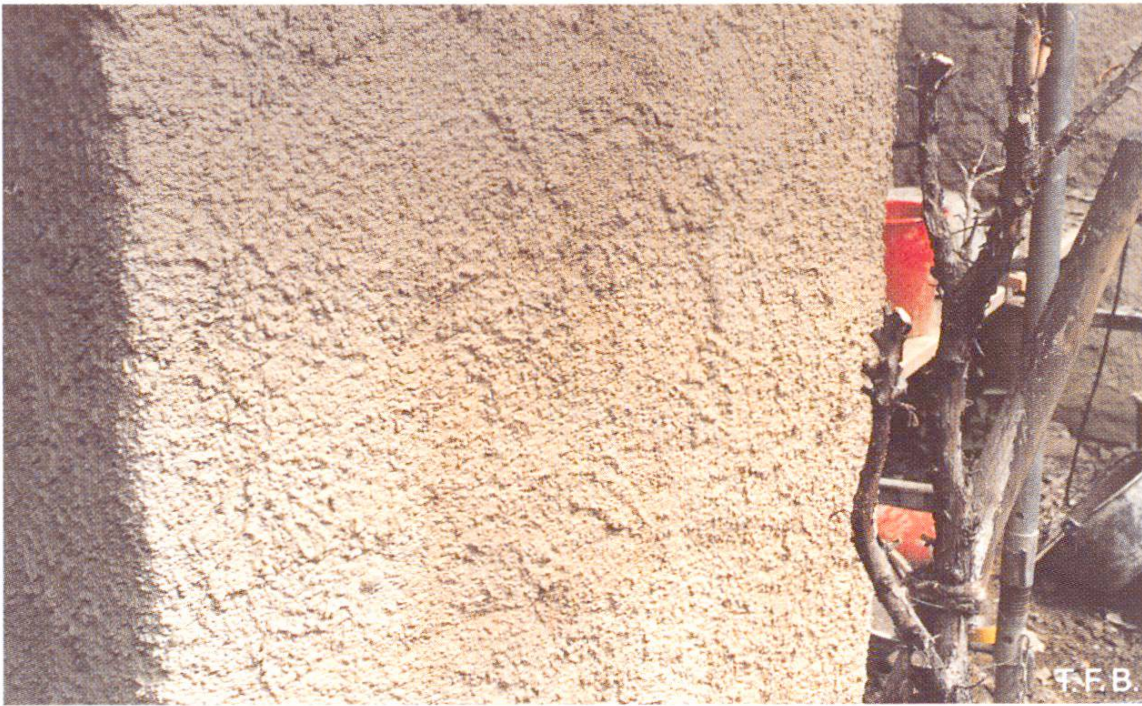
Abb. 8 Vollflächig deckender Anwurf mit HK-Mörtel 0–8 mm (Sandsteinpfeiler einer Kirche).
