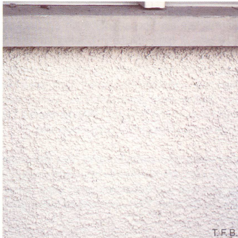
Abb. 14 Kellenwurf als Deckputz (Lindenplatz Pfungen).
