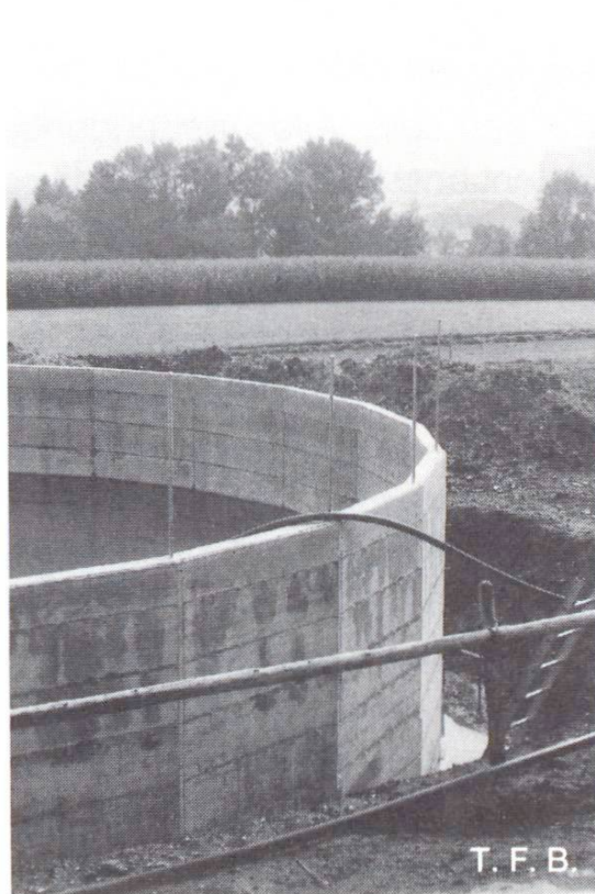
Abb. 13 Vor dem Hinterfüllen der Wände wird eine Dichtigkeitsprobe durchgeführt.
