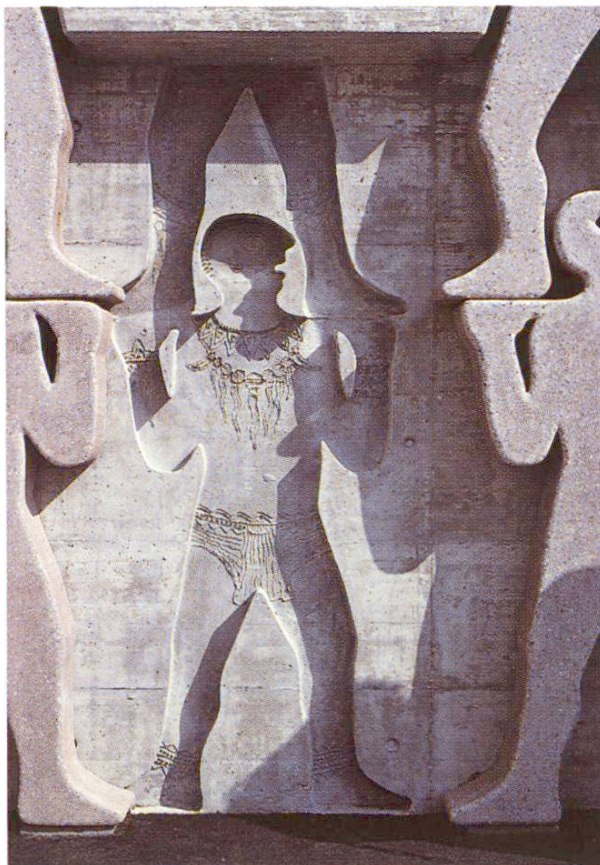
Mauer aus Ortbeton mit Relief
