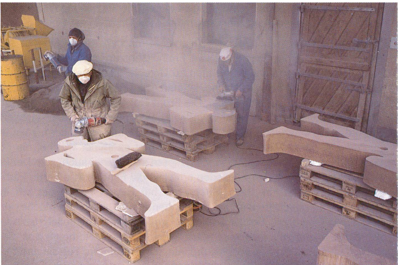
Bearbeiten der ausgeschalteten Figuren. Schleifen von Kanten und Oberflächen
