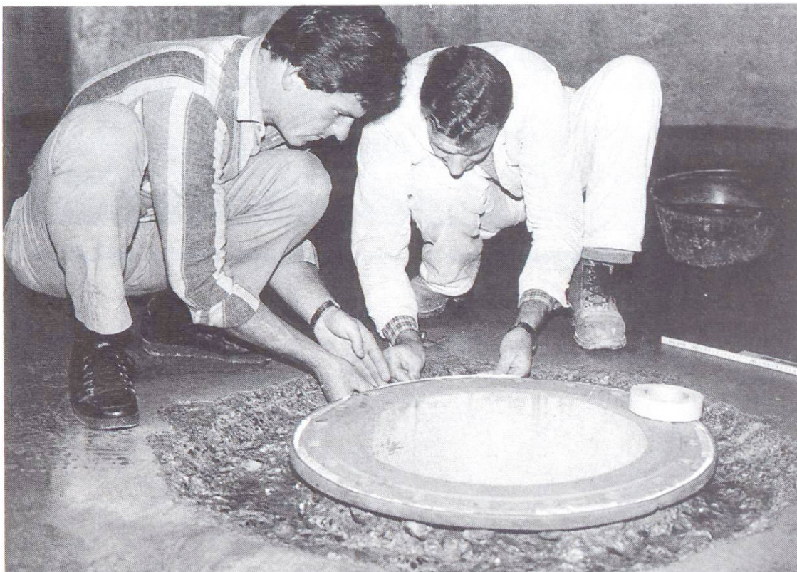
Abb. 6 Sanierung eines Flansches (vgl. Abb. 4) mittels Zementpassivierung.
