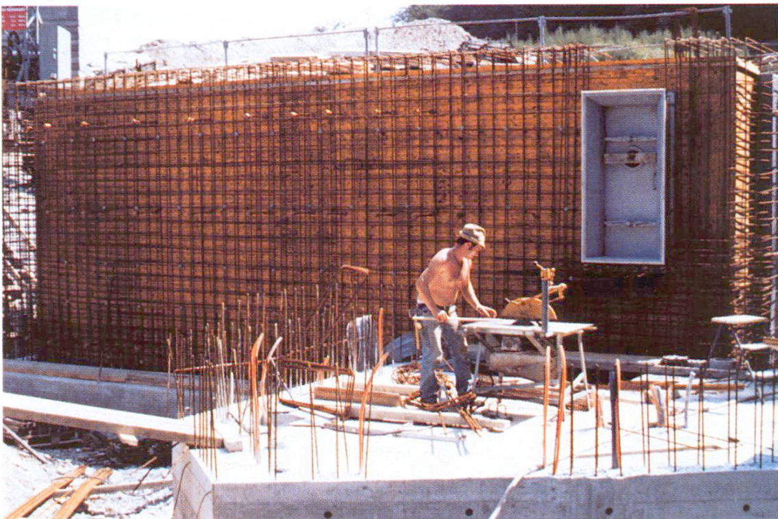
Abb. 12 Schalen und Armieren der Wände. Einlegen der Metallbauteile: Drucktüre aus Edelstahl.
