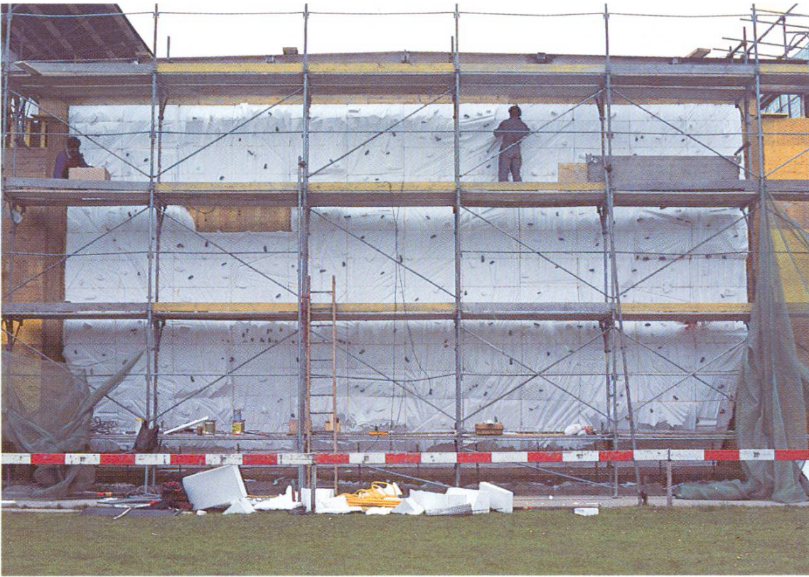
Innenschalung mit bearbeiteten Strukturblöcken, vor dem Armieren und Stellen der Aussenschalung (Bern-Neufeld).
