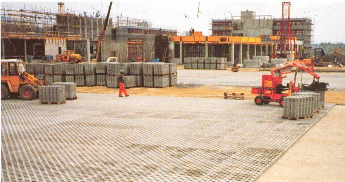
Abb. 4 Verlegen der Rasengittersteine: bei grösseren Flächen maschinell.
