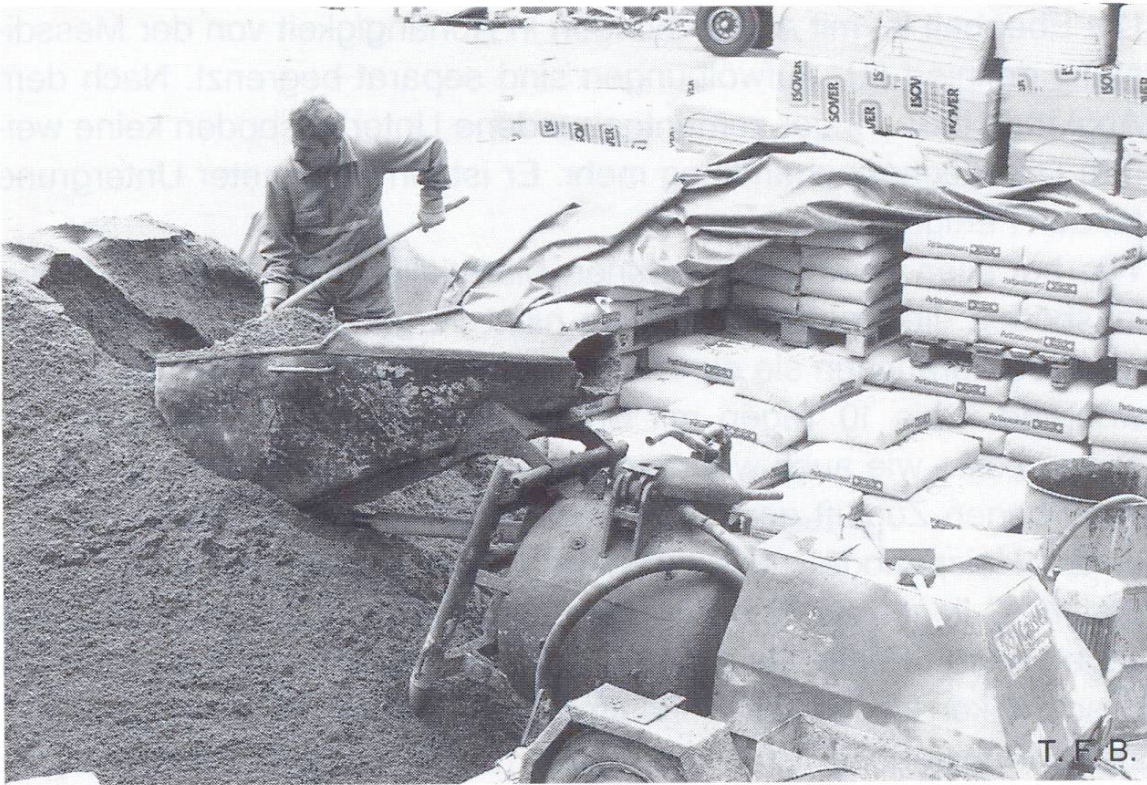
Abb. 2 Mischen des Mörtels und Pumpen zur Einbaustelle
