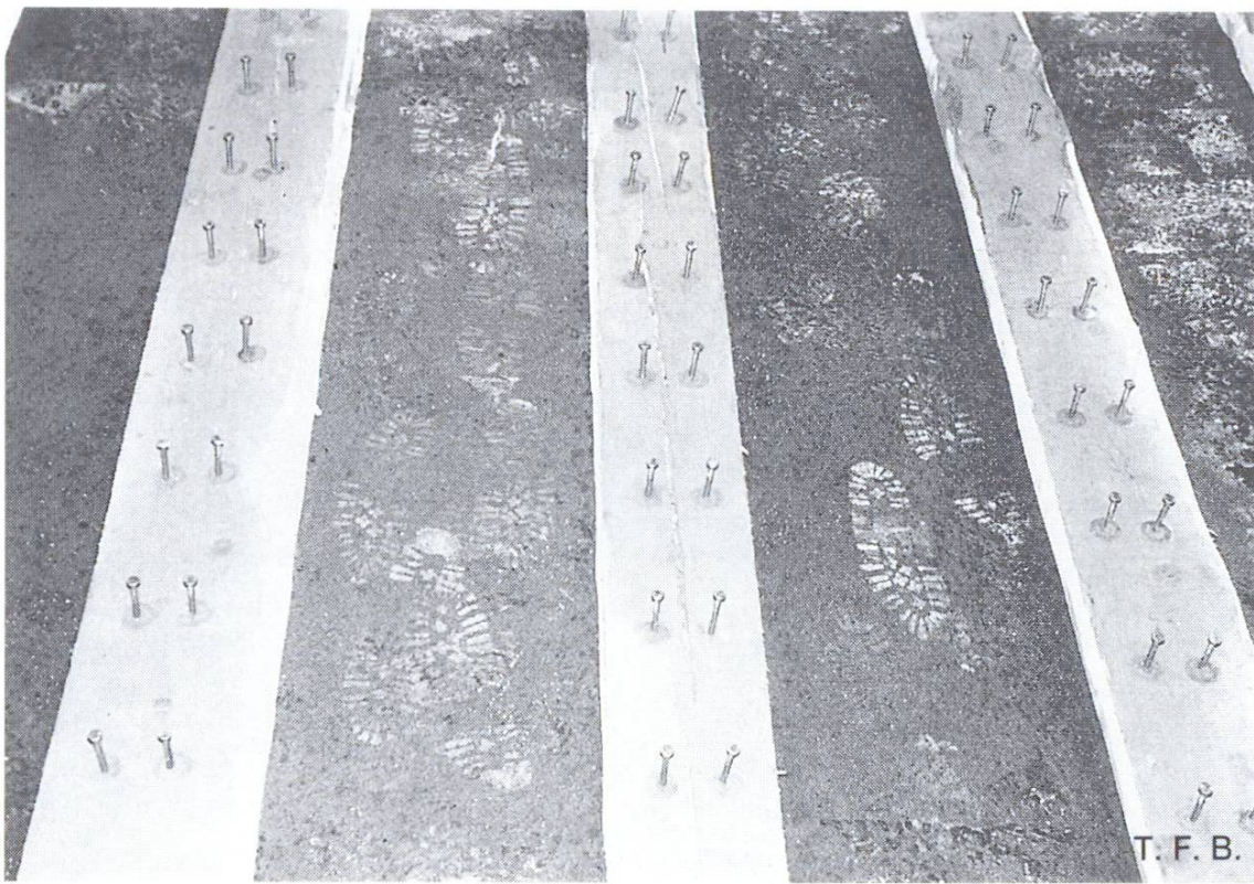
Abb. 5 Aufbau noch mit Nägeln. Beispiel aus dem Jahre 1967/68. In diesem Gebäude wurde mit Leichtbeton gearbeitet
