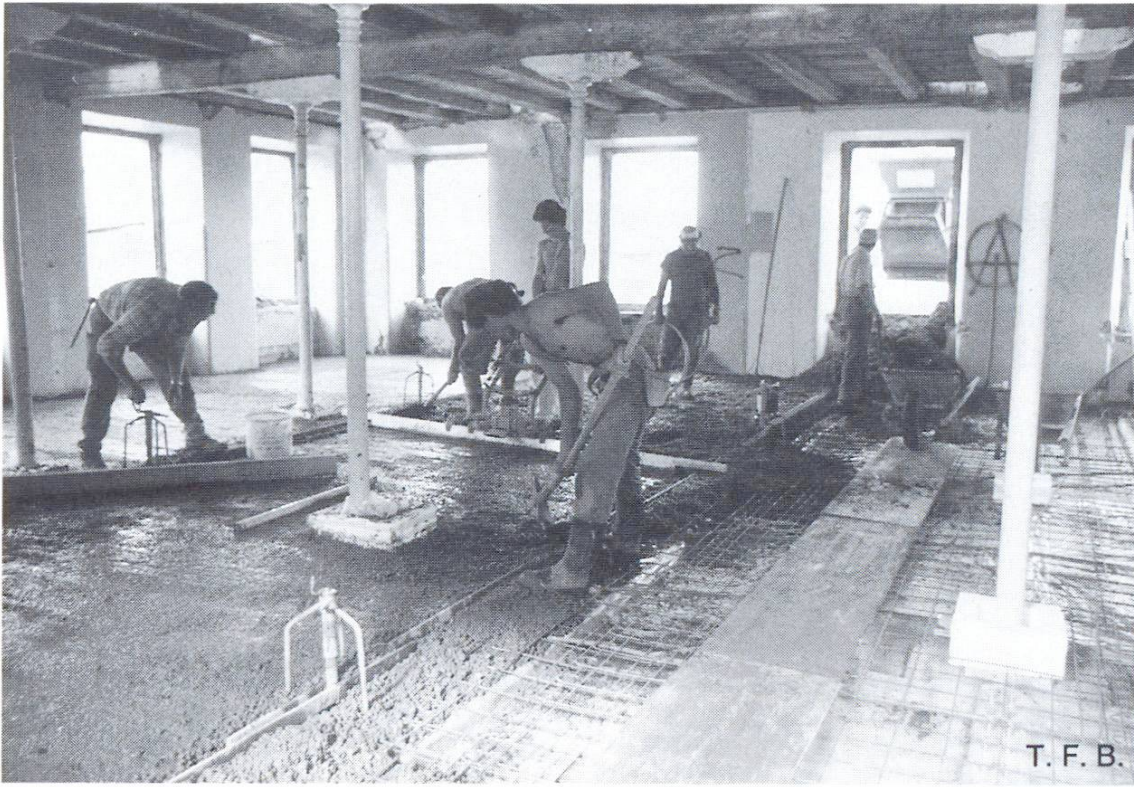
Abb. 9 Betonförderung mit Krankübel ab Umschlaggerät durch Seitenfenster. Transport mit Karrette und Einbringen
