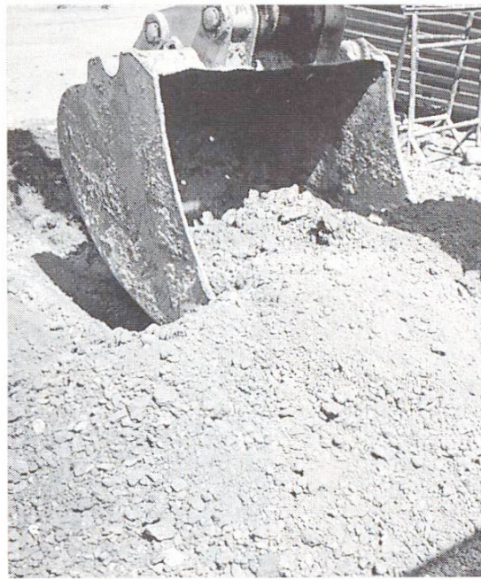
Abb. 3 Mit Kalk stabilisiertes Bodenmaterial (verarbeitbar, krümelig)
