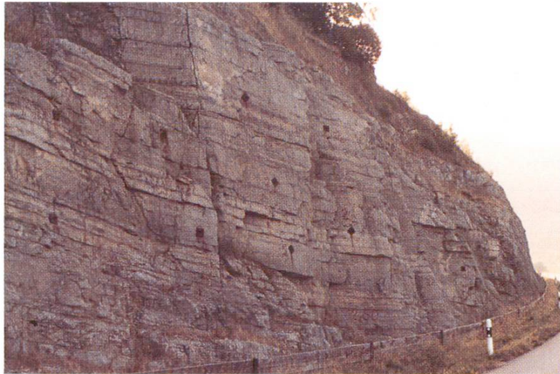
Abb. 15 Südlicher Teil vor der Sanierung
