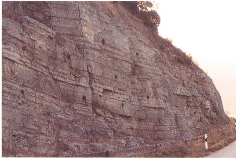
Abb. 15 Südlicher Teil vor der Sanierung
