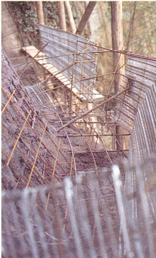
Abb. 6 Bewehrung für Pflanzenkörbe
