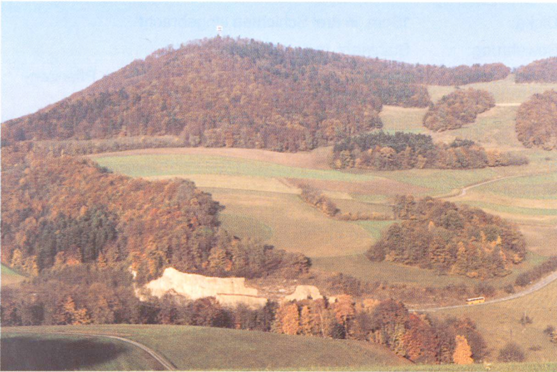
Abb. 12 Ansicht der sanierten Felswand. Das Objekt befindet sich in freier Landschaft. Der Einschnitt war durch die Linienführung der Strasse bedingt und vor der Sanierung nur örtlich durch verankerte Netze gesichert
