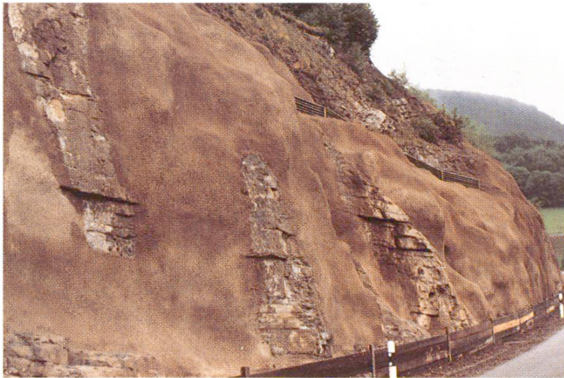
Abb. 16 Südlicher Teil nach der Sanierung
