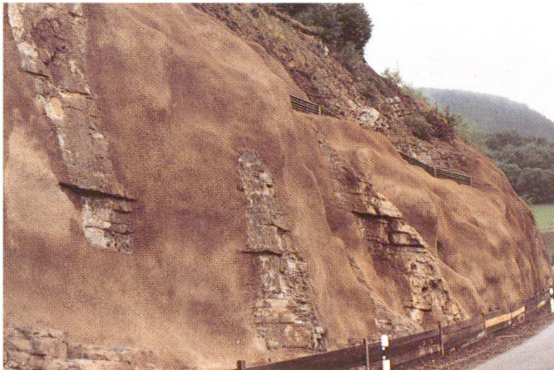
Abb. 16 Südlicher Teil nach der Sanierung
