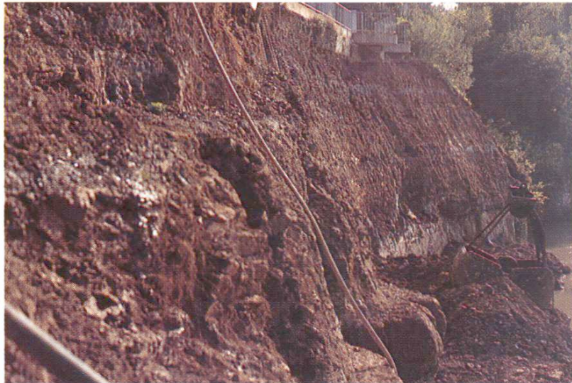
Abb. 9 Abtrag (wechselnde Hangneigung!)
