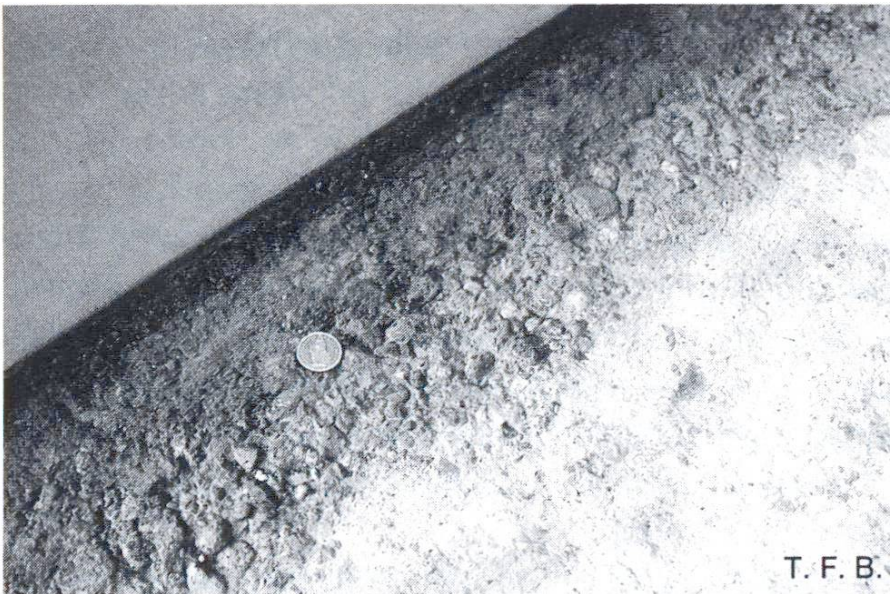
Abb. 9 Arbeitsfuge im Hartbeton. Am folgenden Tag wird hier satt anbetoniert.
