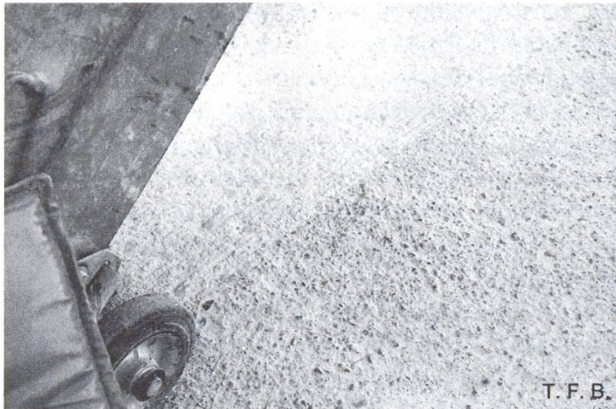
Abb. 5 Beispiel eines guten Untergrunds. Einmaliges Überfräsen genügt.
