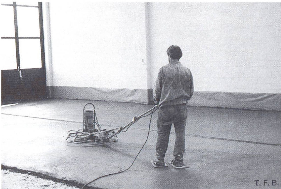
Abb. 3 Oberflächenbehandlung mit der Glättmaschine. Fein abgerieben mit Scheibe bzw. abgeglättet mit Flügel.
