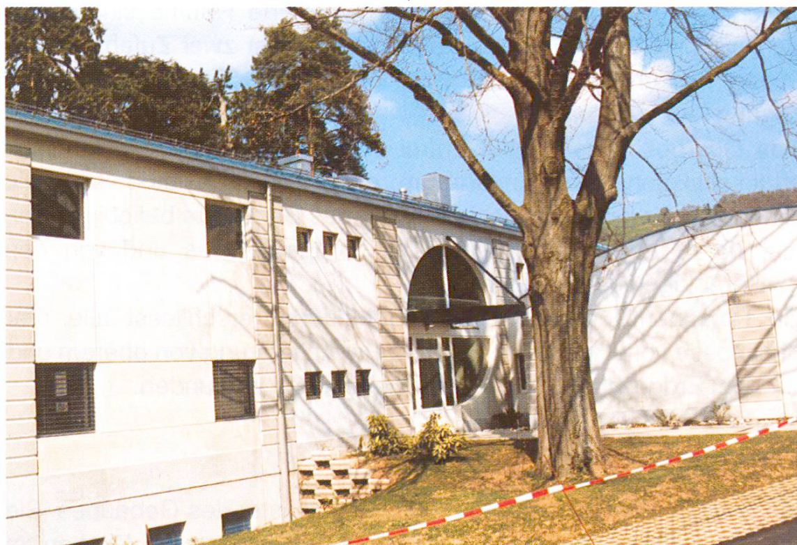
Abb. 1 Kundeneingang (Ost, Seite Autobahn)
