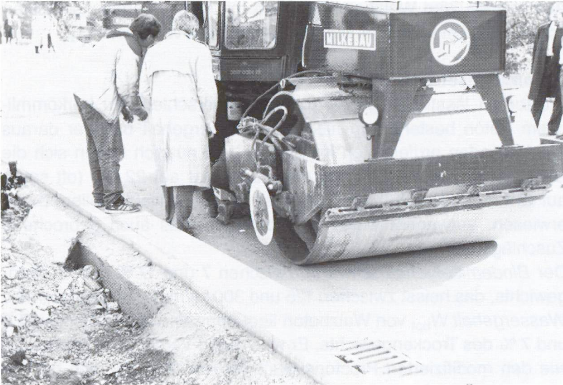
Verdichten von Walzbeton mit Vibrationswalze.
