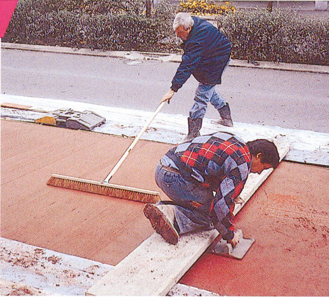
Eine interessante Anwendung von Betonzusatzstoffen: eingefärbte Betonbeläge bei Bushaltestellen.
